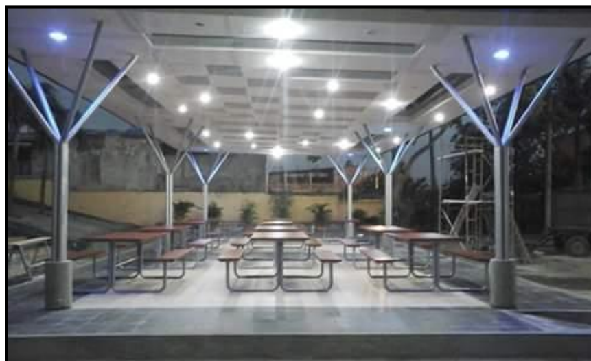
Imagen 5. Área de estar terminada, con iluminación
