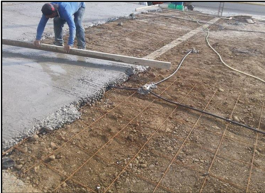
Imagen 2. Fundición de Contra piso
