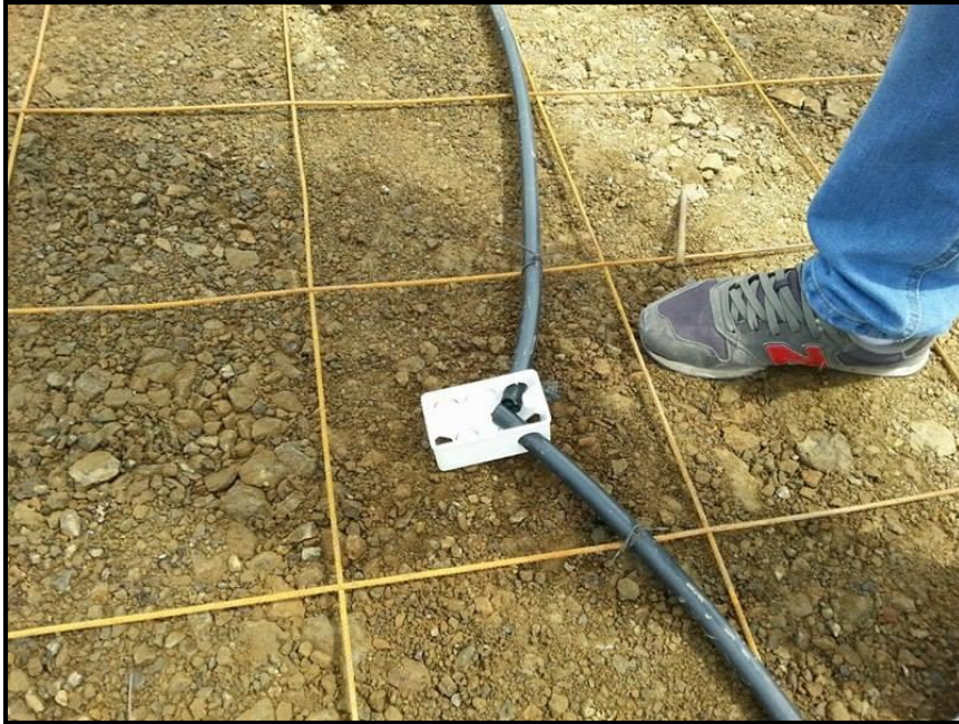
Imagen 1. Colocación de las Instalaciones Eléctricas
