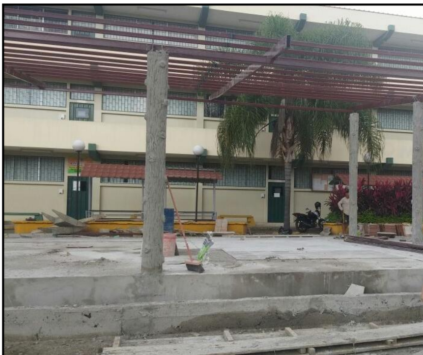
Imagen 4. Colocación de la Estructura Metálicas
