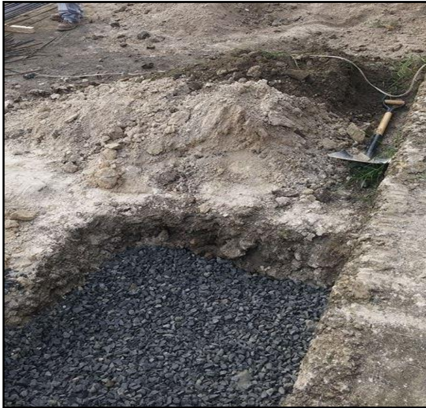
Imagen 3. Excavaciones para el sistema de agua lluvias
