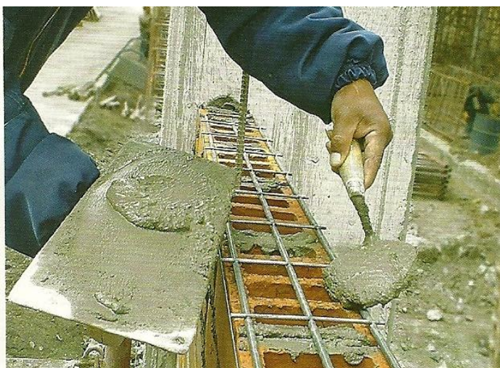
Gráfico # 12.- Utilizacion de escalerilla en mampostería armada.
