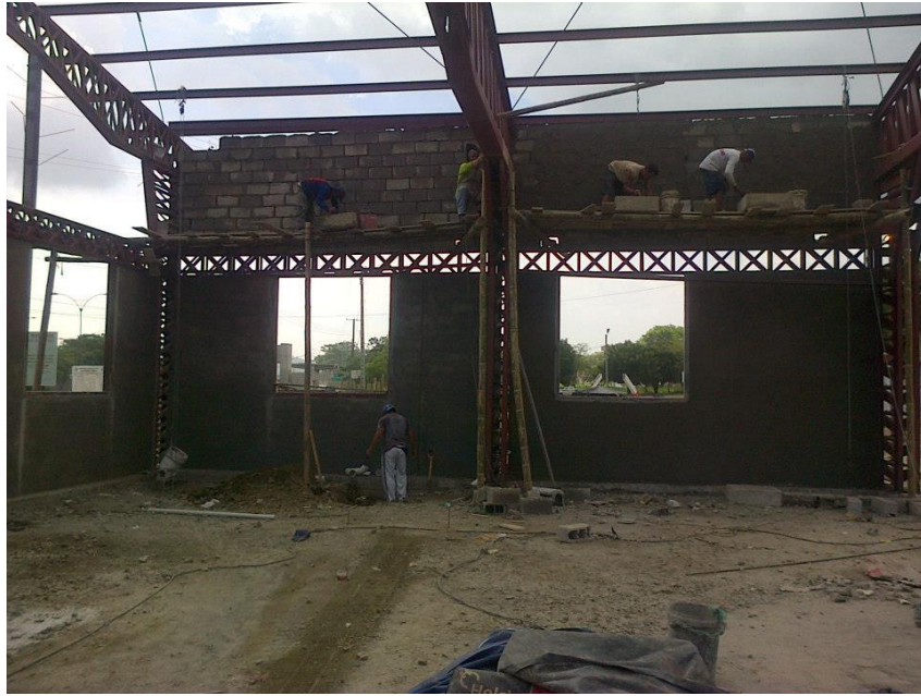
Colocación de la mampostería confinada en la Biblioteca General.
