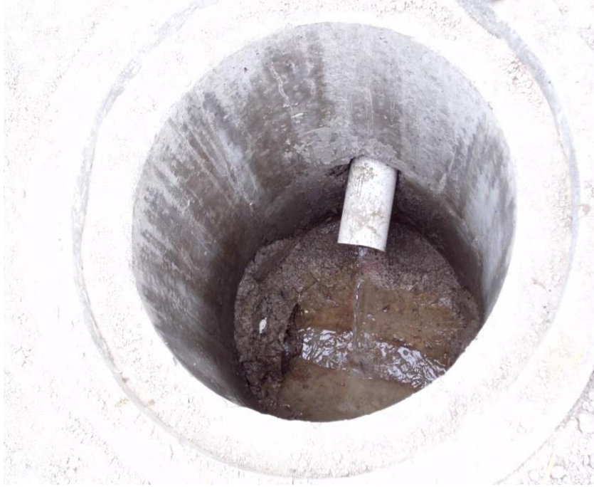
Imagen 20: Caja de revisión abierta.
