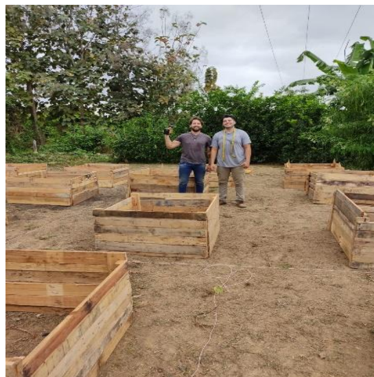
Anexo 2. Construcción de las camas para la materia orgánica
