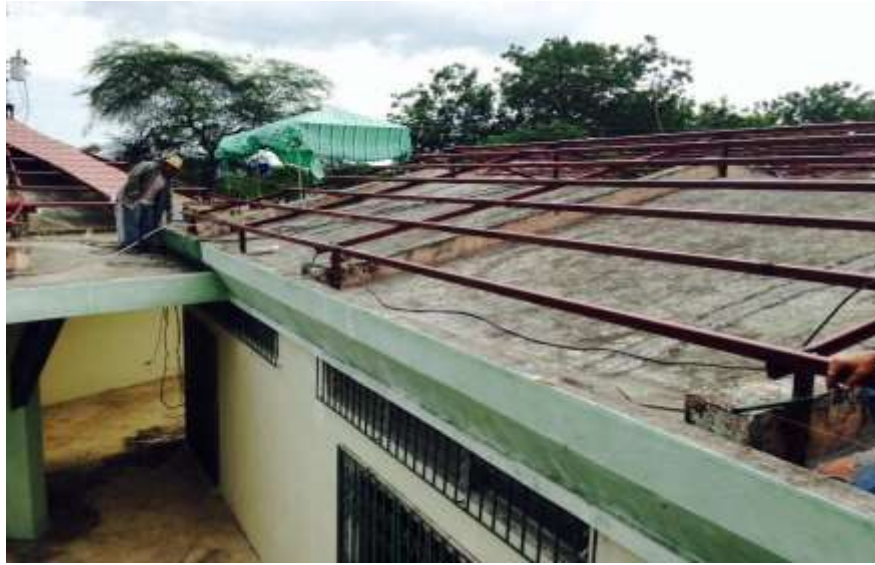
Ejecución de la estructura metálica.
