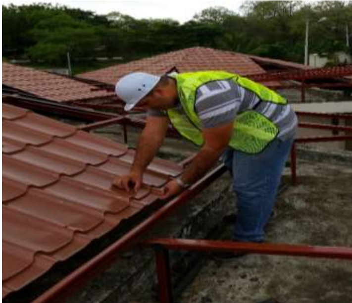
Inspeccionando la colocación de la cubierta.
