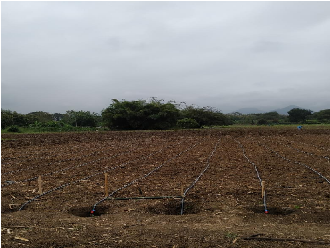
Anexo 2: Sistema de riego antes de la siembra.
