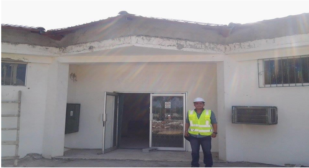
Foto #5 Adecuación de la fachada.
