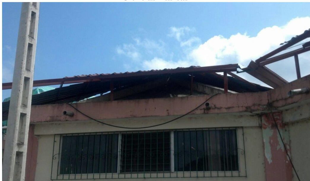
Foto #1 Fachada antes de la Rehabilitación del Laboratorio del Instituto de Ciencias Básicas
