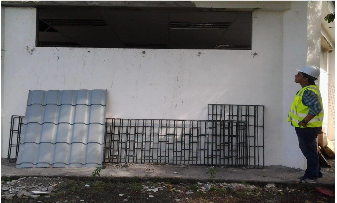
Foto # 9 Adecuación de las rejas metálicas.
