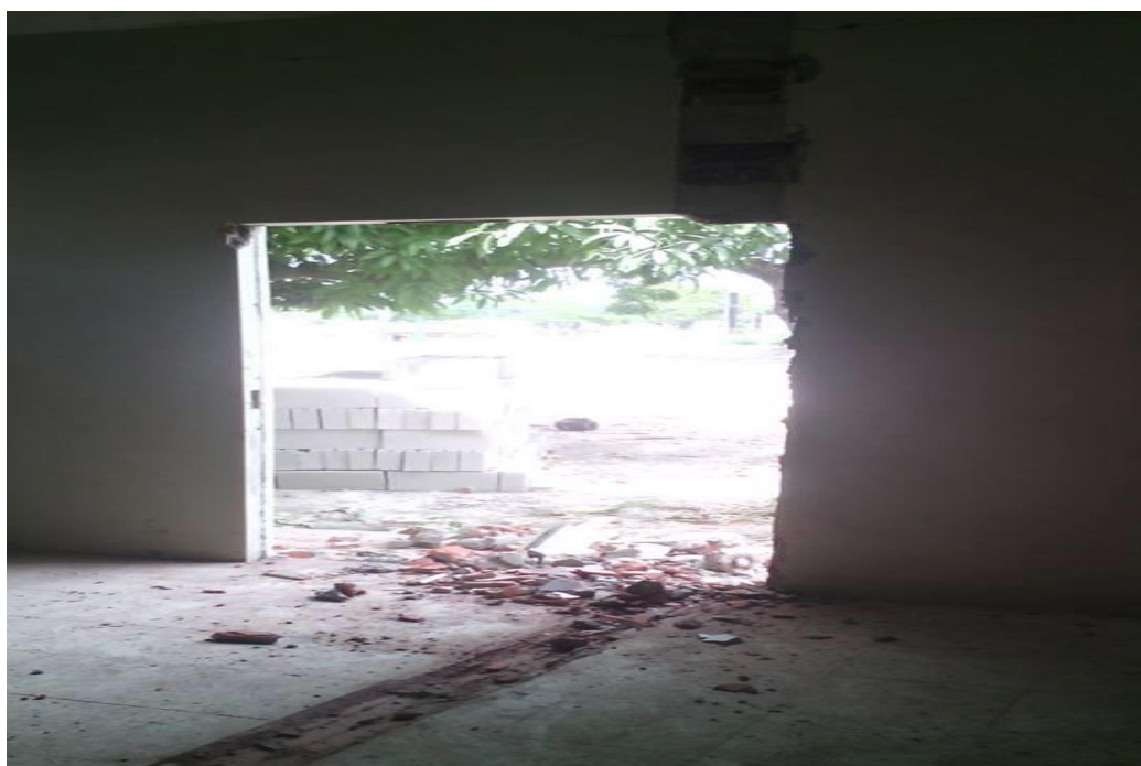
Foto #2 Rehabilitación de las ventanas, puertas y rejas del I.C.B
