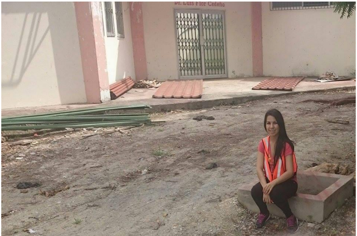
Foto #6 Reparación de las rejas metálicas.
