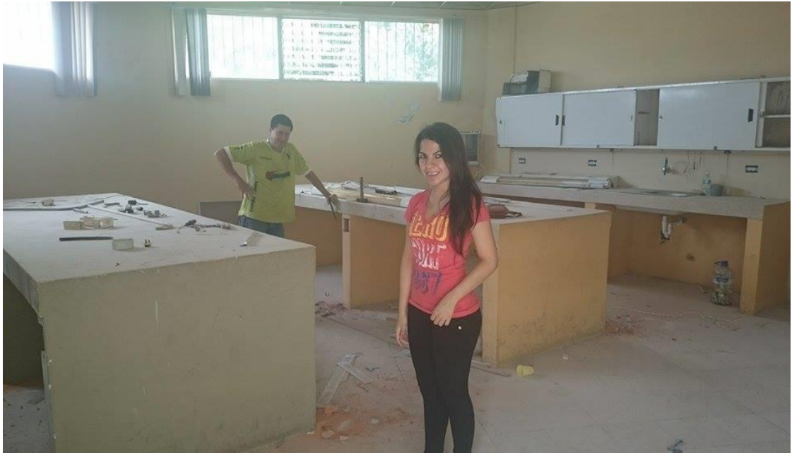
Foto #7 Reparación de vidrios de ventanas que se están adecuando.
