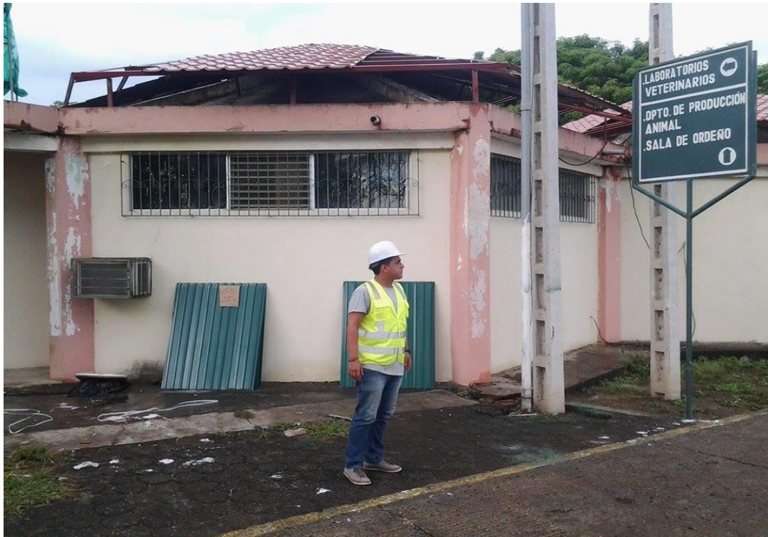
Foto # 8 Realizando mantenimiento.
