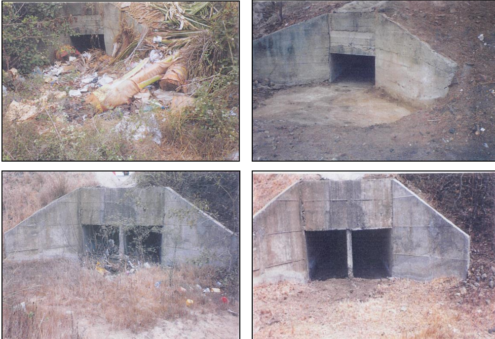
Limpieza de alcantarillas (Micro-empresa “Unidos Trabajando”)
