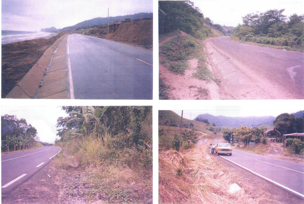
Limpieza y reparación de cunetas (Micro-empresa “Coaque”)
