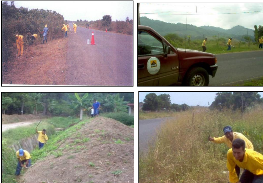
Labores de desmonte (Micro-empresa “Ruta del Sol”)
