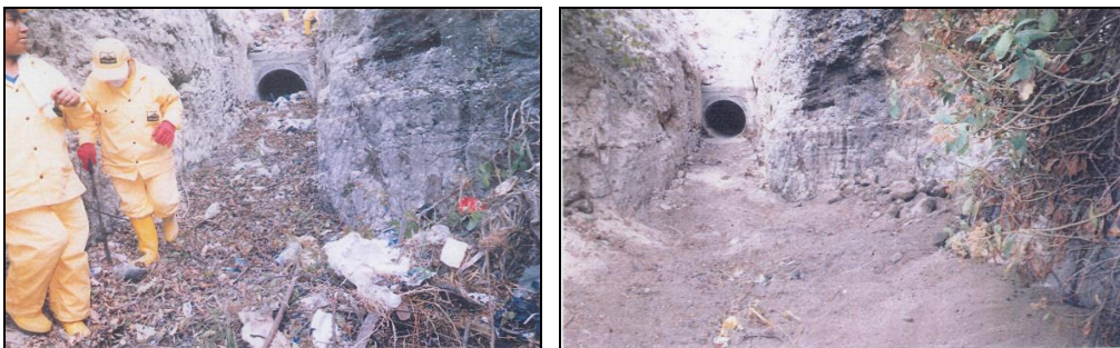
Limpieza de alcantarillas (Micro-empresa “Río Jama”)
