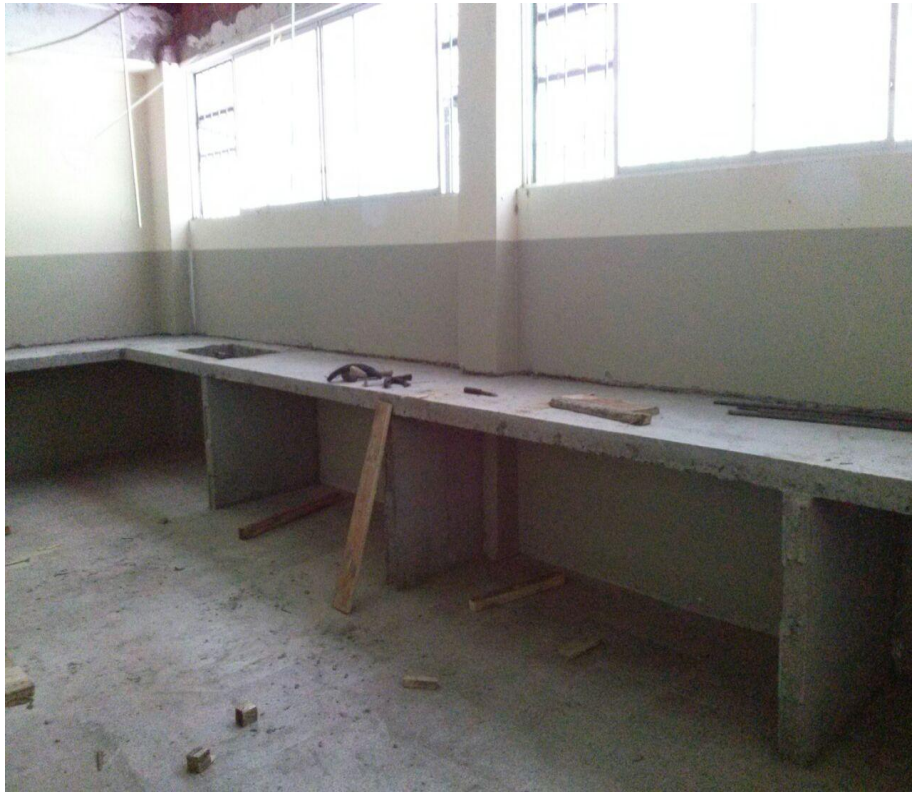
Encofrado y armado de meson.
