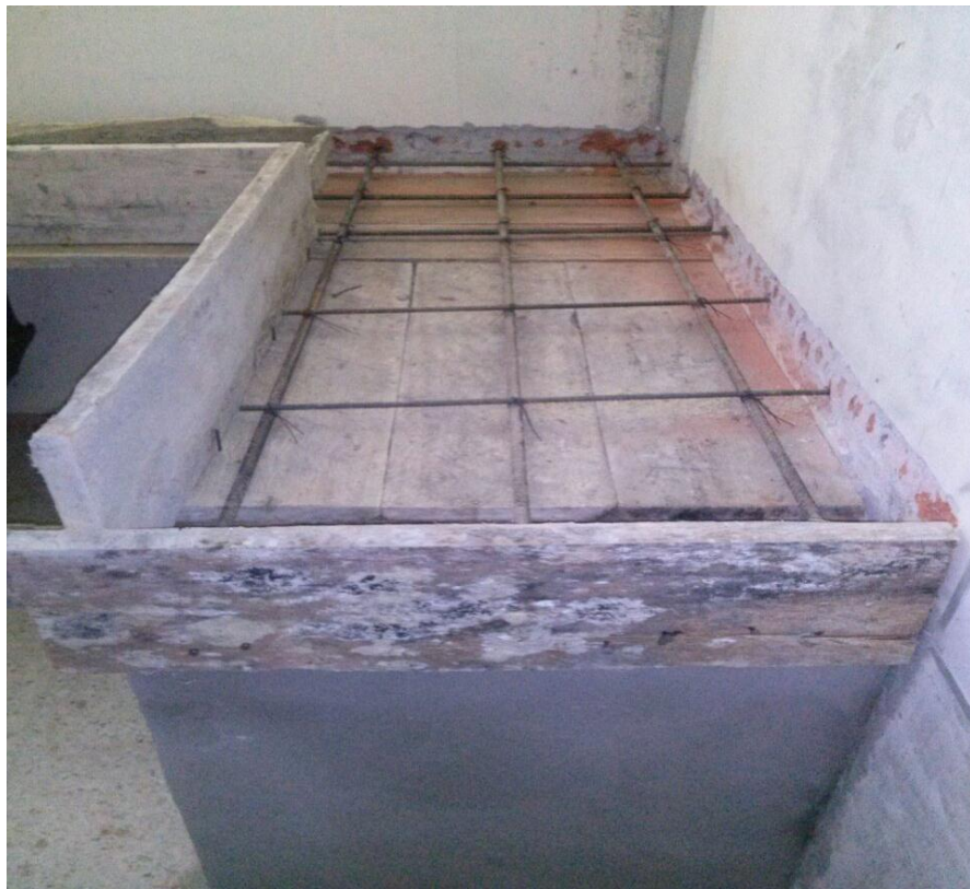
Encofrado y armado de meson.
