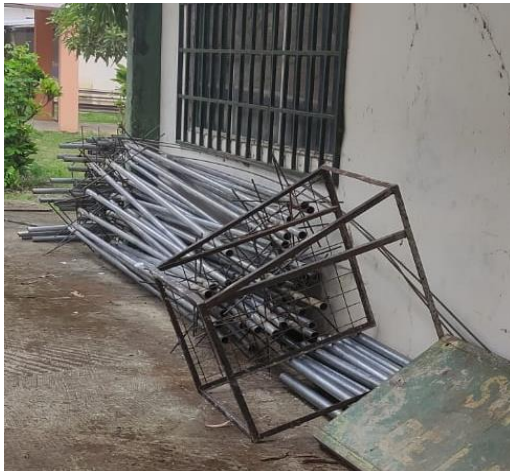
Ilustración 7 Elaboración de los módulos estructurales galvanizados.
