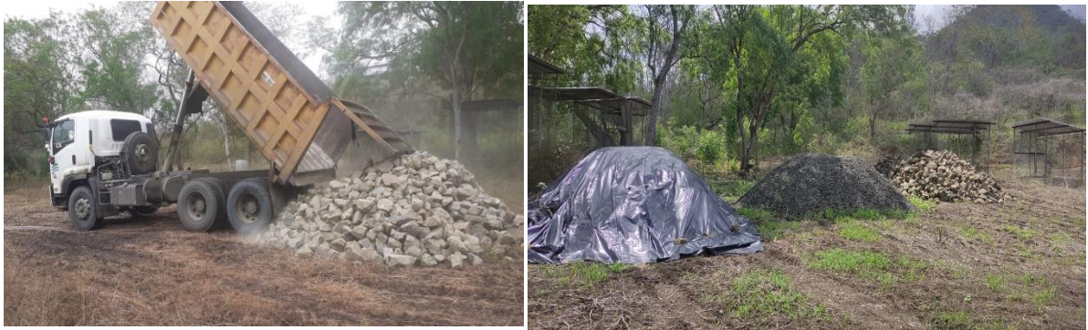
Ilustración 9 Recepción de material pétreos.
