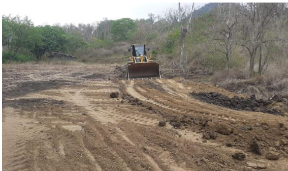
Ilustración 5 Limpieza y Relleno del terreno.
