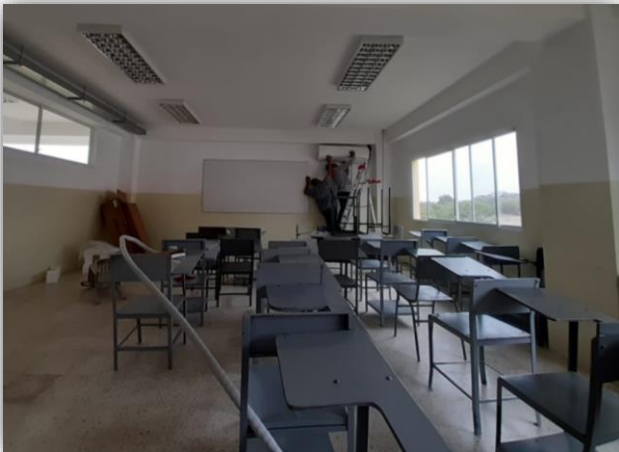
MANTENIMIENTO PREVENTIVO DE LA UNIDAD INTERIOR
