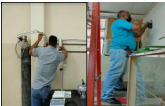
Fig. 1. Instalación del cableado para el espectrofotómetro
