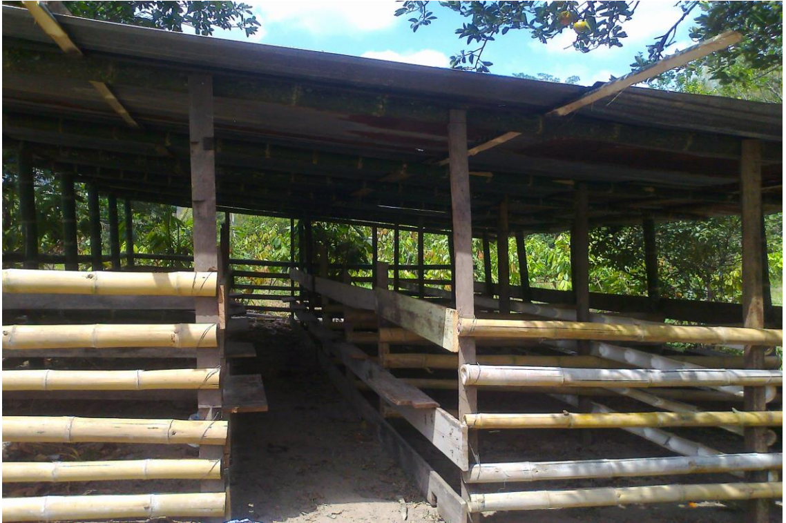
Grafica 12.- ADECUACIÓN DEL CORRAL
