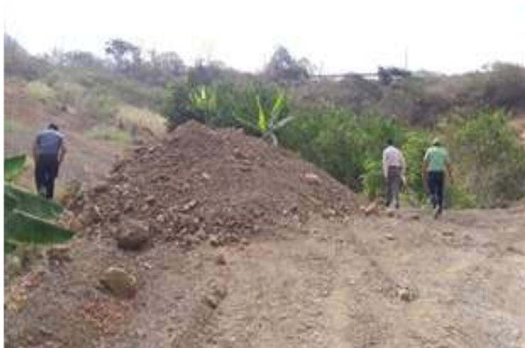
Ejecución de la obra.
