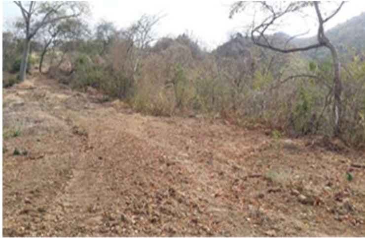
Inicio de la obra.
