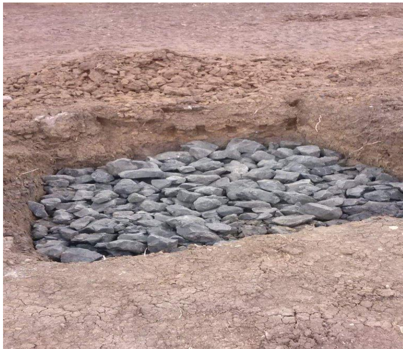
COLOCACION DE MATERIAL FILTRANTE EN EXCAVACIONES DE PLINTOS
