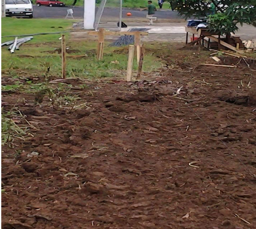
ARMADA DE CABALLETES PARA REPLANTEO DE ESTRUCTURA
