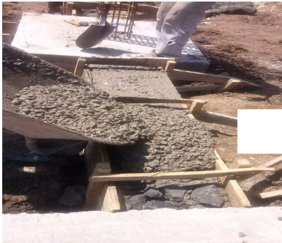
FUNDICION DE MUROS DE HORMIGON CICLOPE
