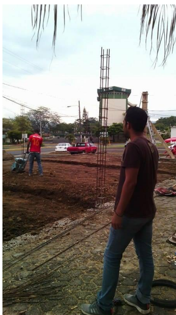
Imagen 6.- Compactación del terreno
