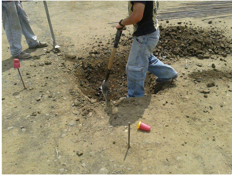
Imagen1.- Excavación para los plintos
