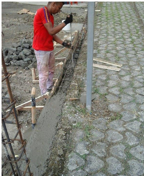
Imagen 4.- Fundición de los muros y cadenas de amarres
