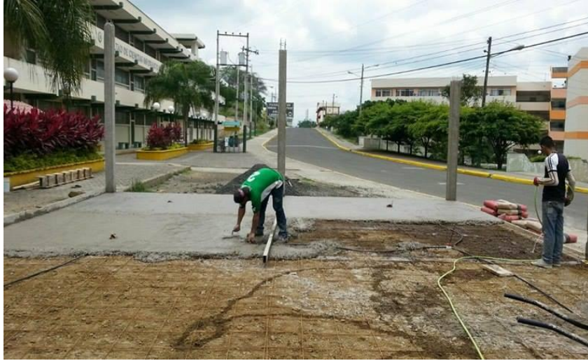
Imagen 7.- Fundición del contrapiso
