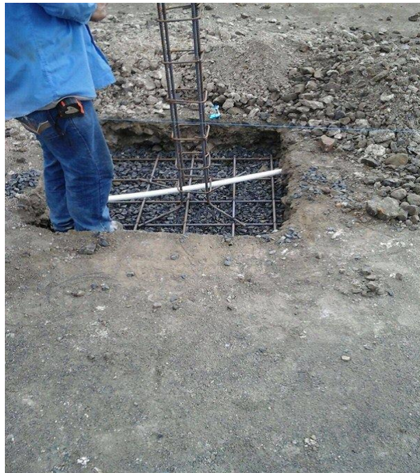
Imagen 2.- Armado del plinto y columna
