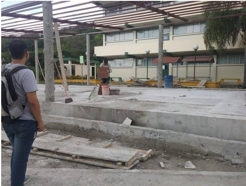
Imagen 8.- Implementación de la estructura metálica para la cubierta
