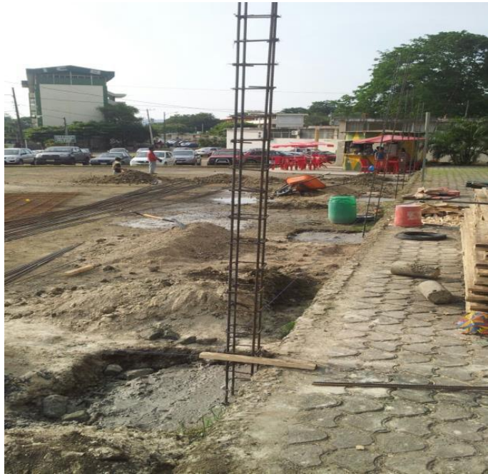
Imagen 3.- Fundición de los plintos
