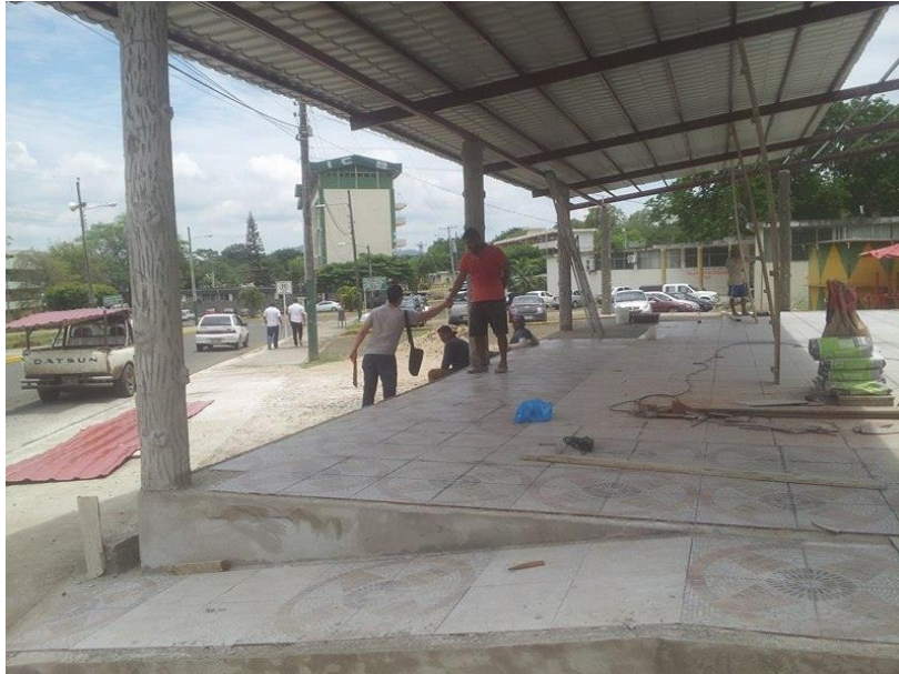
Figura 9.- Colocación de cerámica
