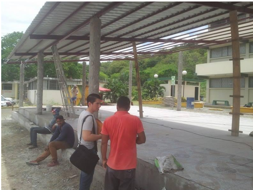
Figura 10.- Colocación de la cubierta
