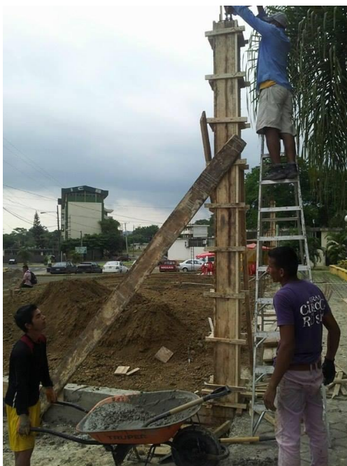
Imagen 5.- Fundición de columnas
