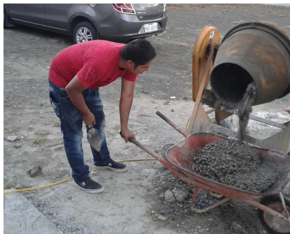
Contenido: Extracción del hormigón para las muestras
