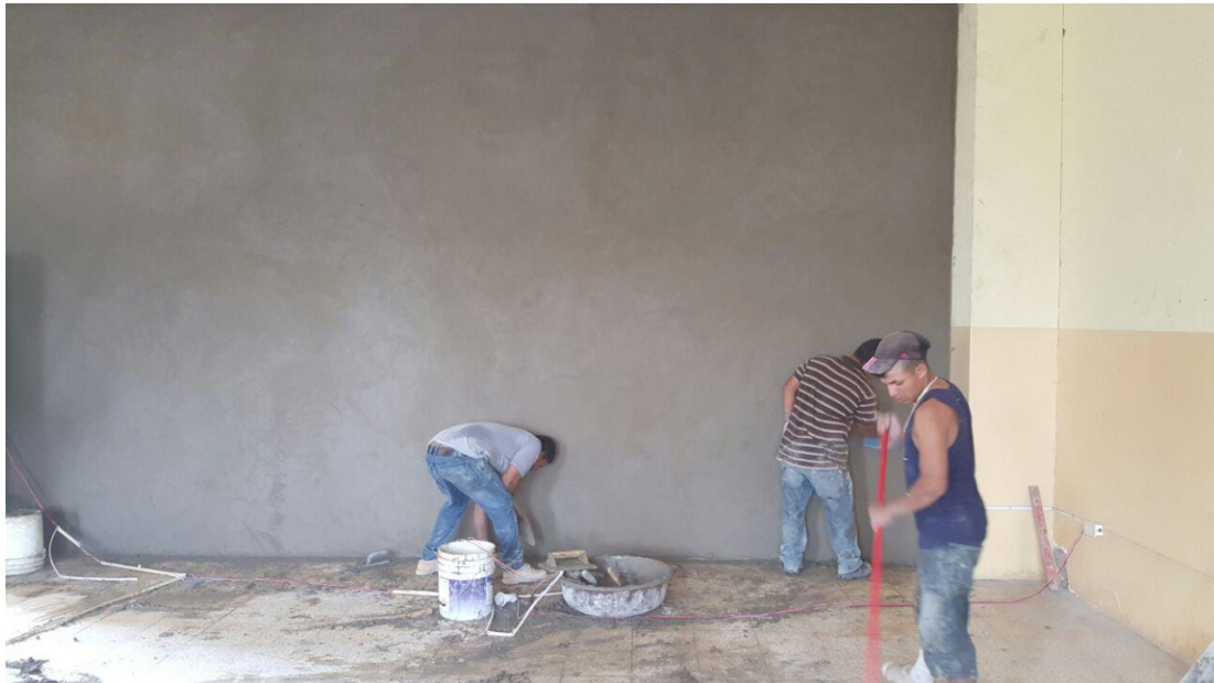
Imagen 20. Enlucido en la mampostería confinada del edificio del Instituto de Ciencias Básicas.
