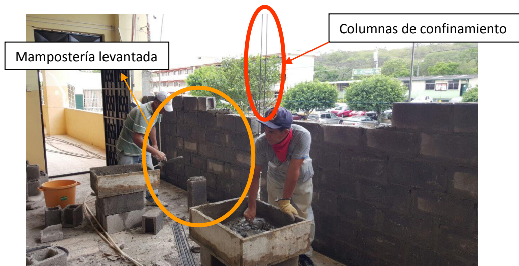
Imagen 15. Evidencia del proceso de construcción en el edificio del Instituto de Ciencias Básicas de la Universidad Técnica de Manabí.
