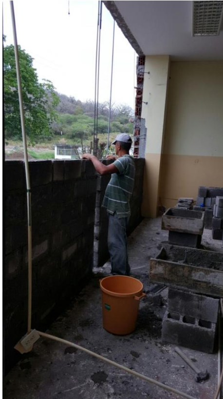
Imagen 18. Levantamiento de las paredes de bloque hueco de 15 cm, empleando confinamiento de columneta y vigueta.
