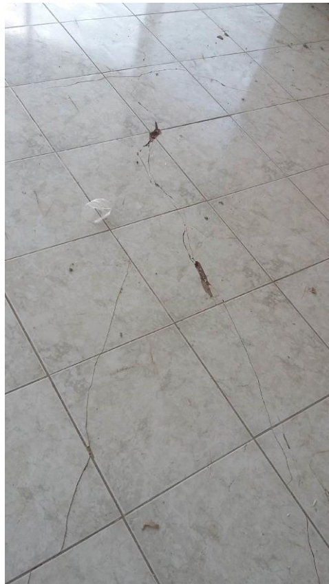
Imagen 14. Fisuras de 1.0 a 3.0 mm en cerámica del Instituto de Ciencias Básicas en la Universidad Técnica de Manabí.
