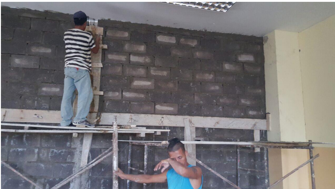
Imagen 19. Levantamiento de mampostería terminada con columnetas y viguetas en cruz.
