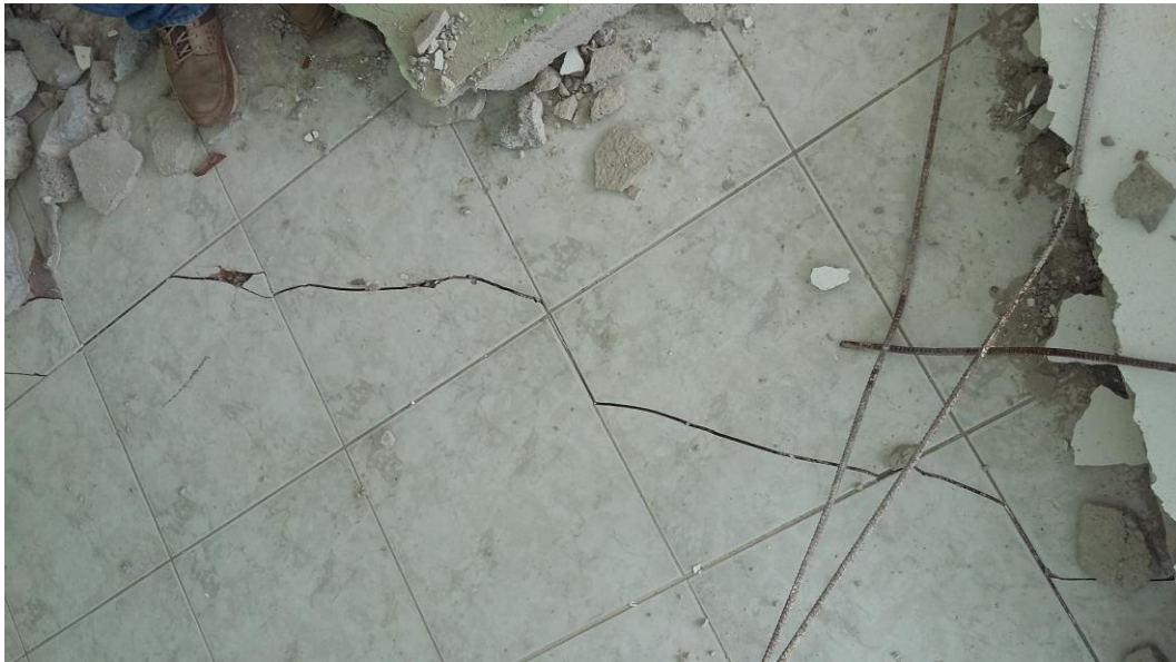
Imagen 13. Fisuras en de aproximadamente 3.5 mm en superficie de la cerámica del Instituto de Ciencias Básicas en la Universidad Técnica de Manabí.
