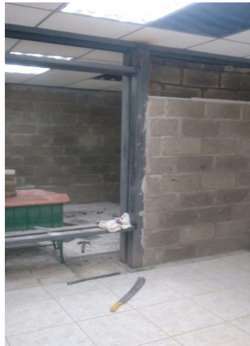
bloqueadas y enlucidas de paredes
