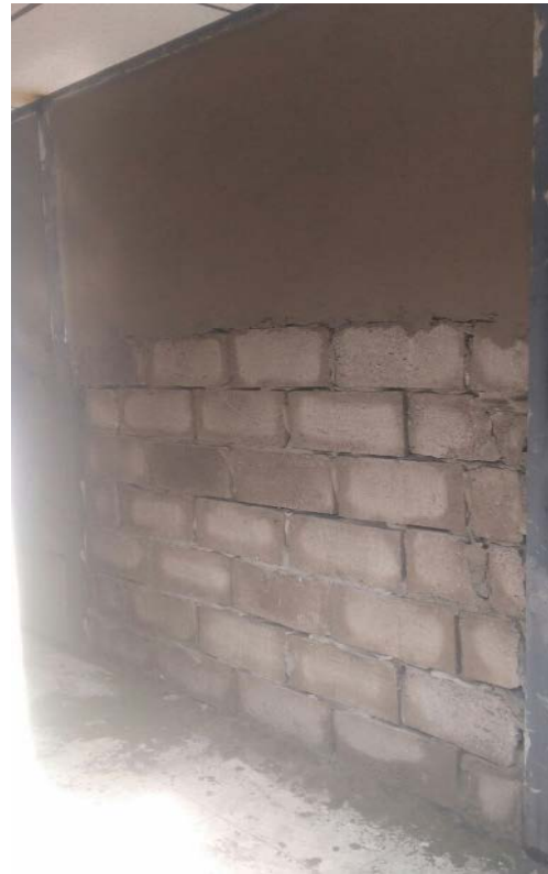
bloqueadas y enlucidas de paredes
