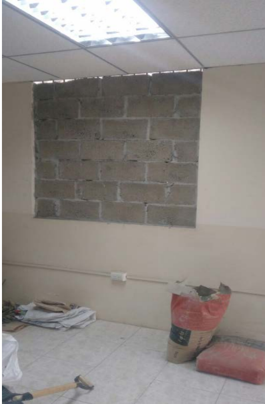
Sellado de ventanas
