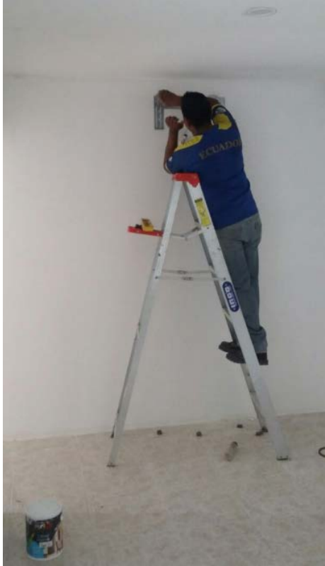
Colocación de los aires acondicionados
