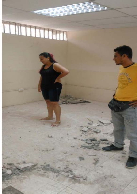
observación de la construcción
