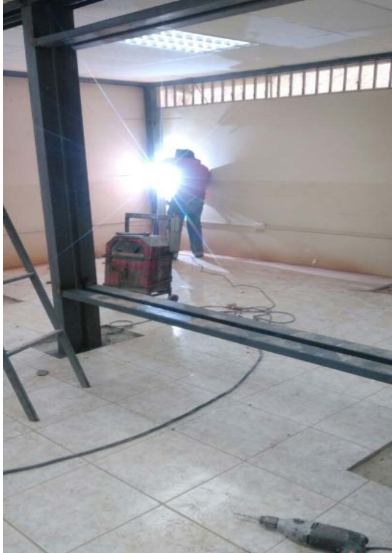
Colocación de estructura metálica
