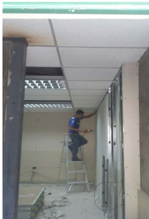
colocación de Gypsum
