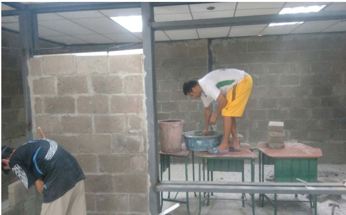
Construcción de paredes
