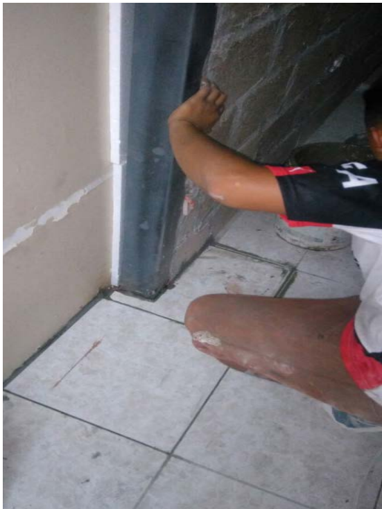
Colocación de cerámica
