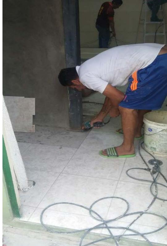
colocación de cerámica en el piso
