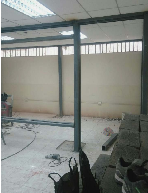
Construcción de estructura metálica
