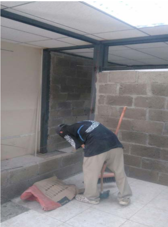
bloqueadas y enlucidas de paredes
