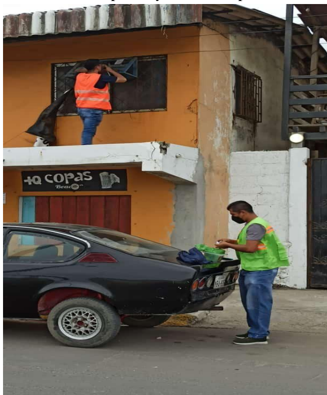
Anexo 9. Mantenimiento de las placas y telas antisépticas en la zona de estudio 4
