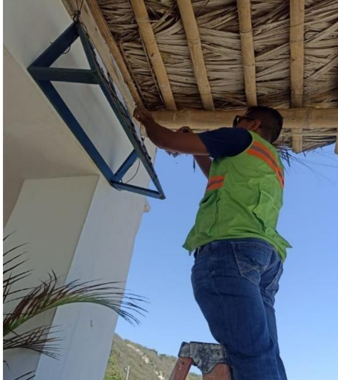
Anexo 6. Mantenimiento de las placas y telas antisépticas en la zona de estudio 1
