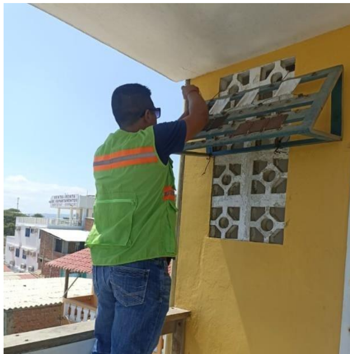
Anexo 7. Mantenimiento de las placas y telas antisépticas en la zona de estudio 2
