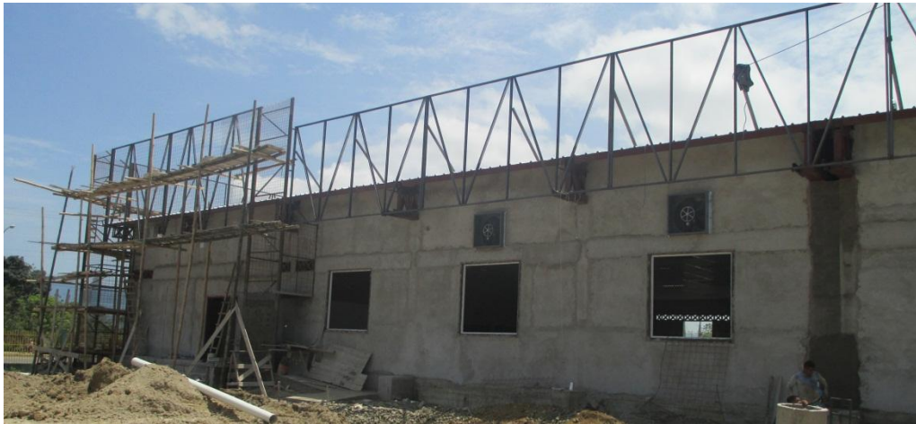
Figura 5: FACHADA DE LA BIBLIOTECA EN CONSTRUCCION
