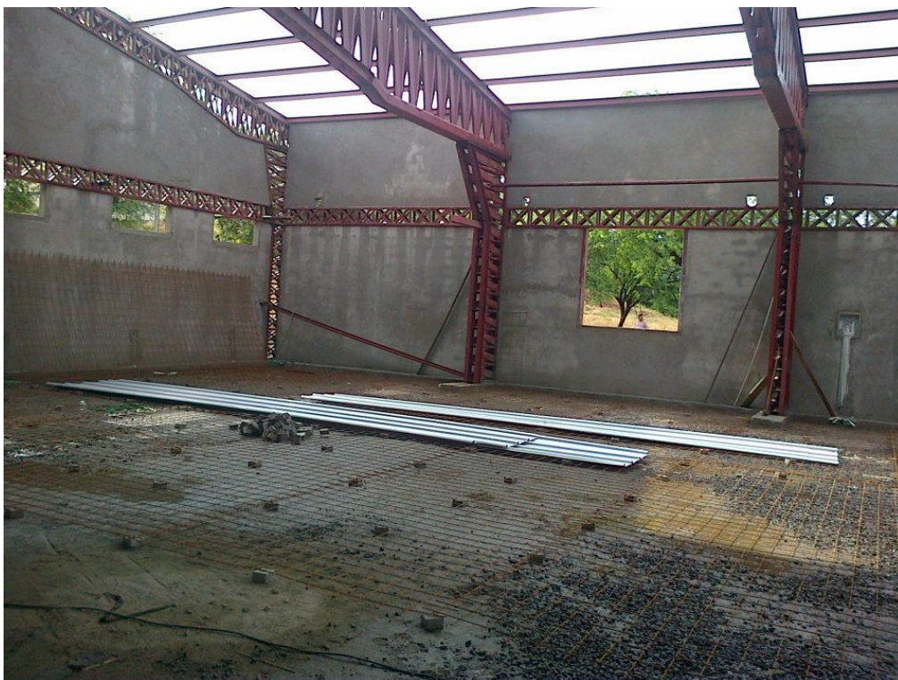
Figura 6: MALLA PARA EL REPLANTILLO
