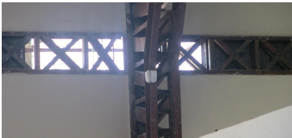
Figura 4: DETECTORES DE MOVIMIENTO
