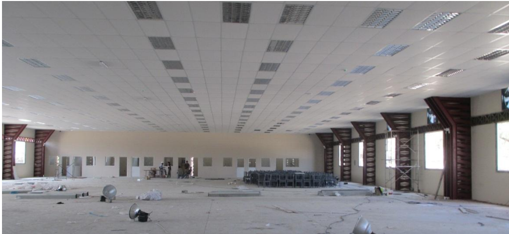
Figura 3: INTERIOR DE LA BIBLIOTECA EN CONSTRUCCION
