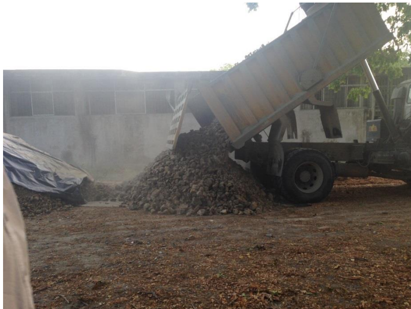
Imagen 2. Descarga del Material de Préstamo
