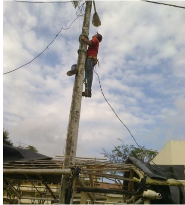
Fotografía 11. Instalación de la energía eléctrica.
