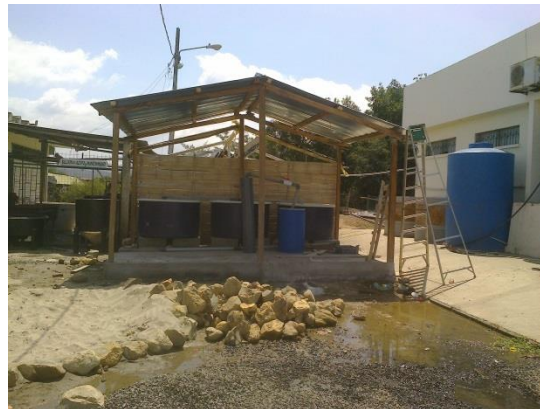
Fotografía 10. Construcción de la cubierta del techo y colocación del zinc.
