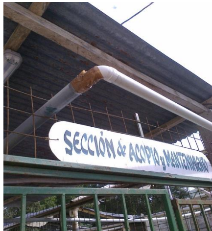
Fotografía 12. Instalación del suministro de aire y distribución a cada tanque.
