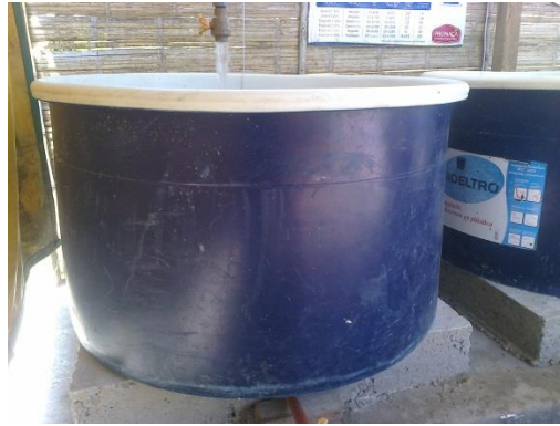
Fotografía 9. Bases de cemento donde se asientan los tanques.
