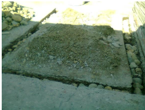
Fotografía 6. Construcción de los muros del piso.
