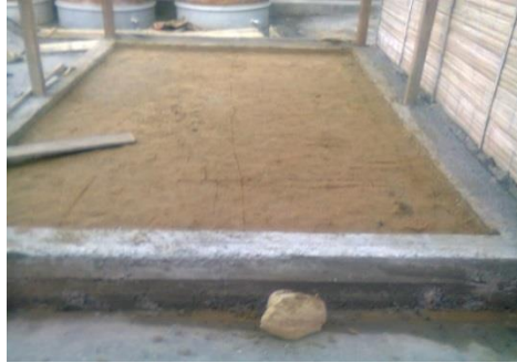
Fotografía 7. Nivelación y compactación del terreno.
