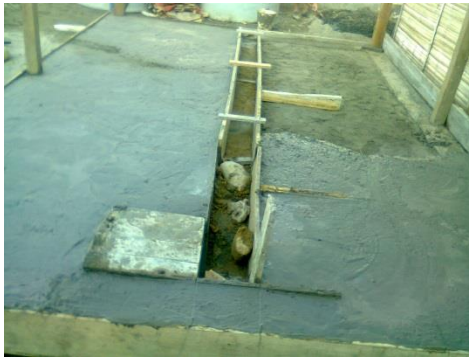
Fotografía 8. Fundición del piso con un drenaje central.
