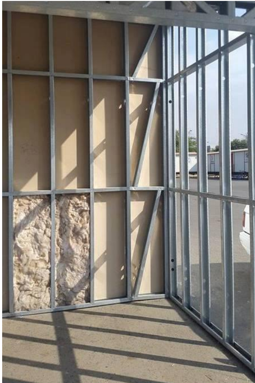
Imagen N° 19: Separación y fijación de la estructura metálica
