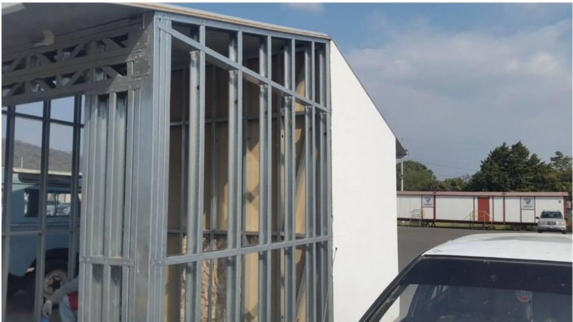
Imagen N° 21: Vivienda tipo en proceso constructivo
