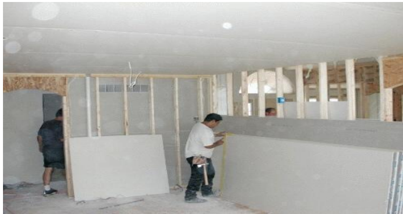
Imagen N° 5: Muros de fibrocemento 22
