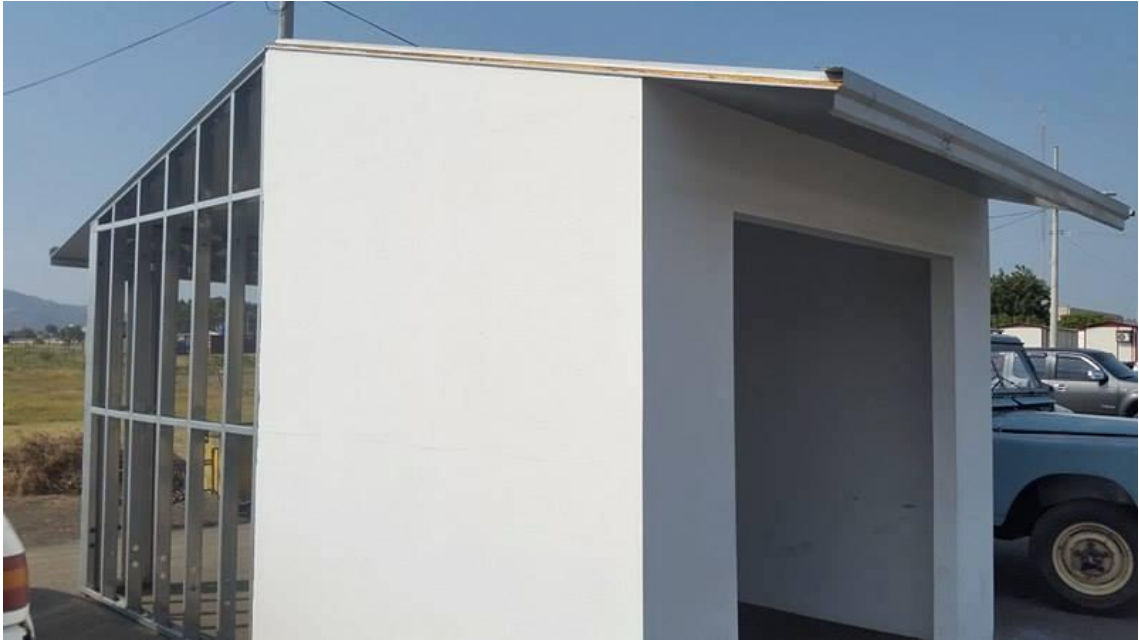
Imagen N° 20: Placas de fibrocemento fijadas a la estructura metálica
