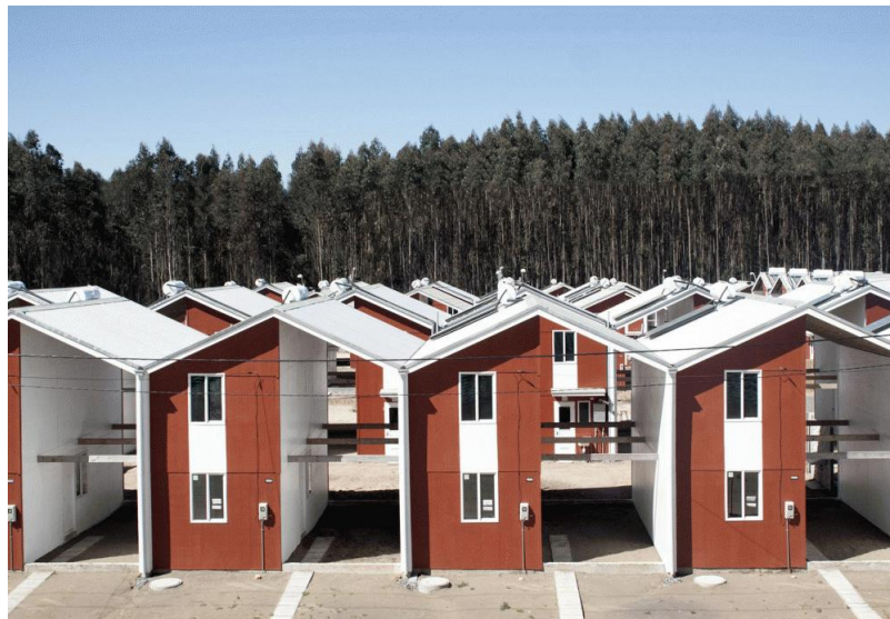
Imagen N° 7: Fachadas de viviendas con fibrocemento 26
