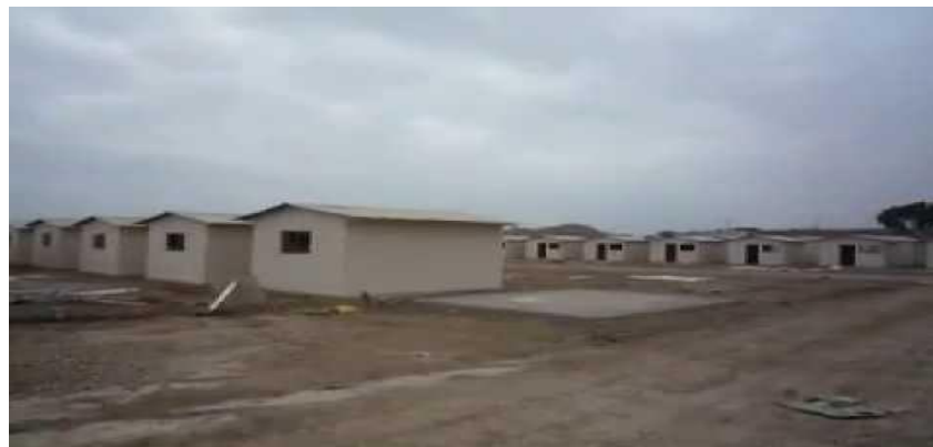
Imagen N° 4: Conjunto habitacional con material de fibrocemento 20
