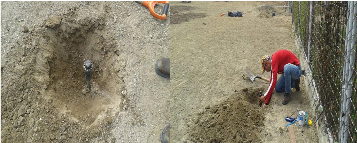
25 Instalación de aspersores
