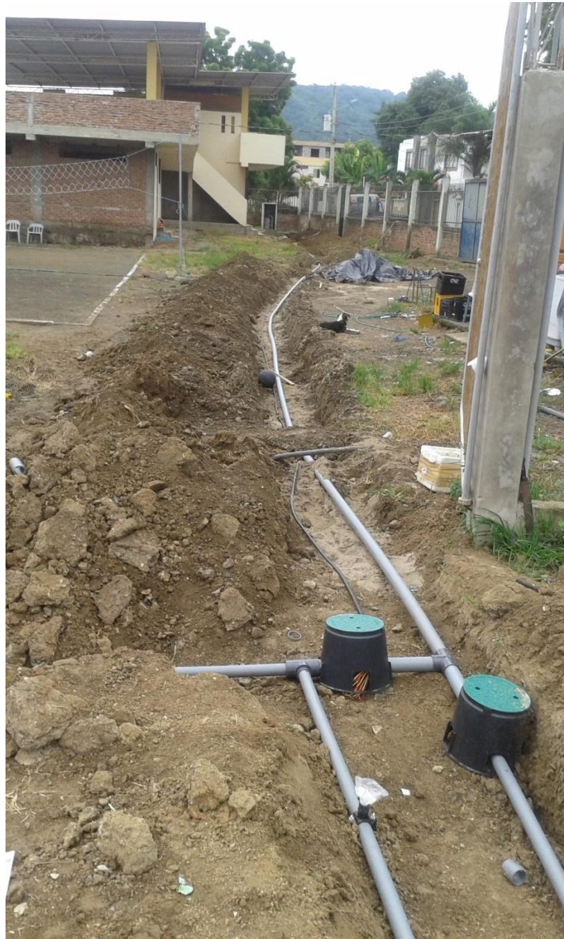
23 Instalación de la red de tuberías, incluido las electroválvulas
