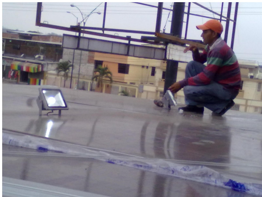
INSTALACIÓN DE LOS REFLECTORES LED DEL LETRERO
