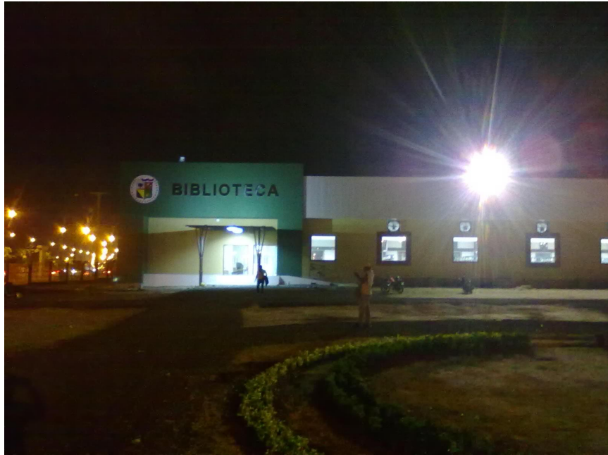
VISTA DE LA ILUMINACIÓN TERMINADA
