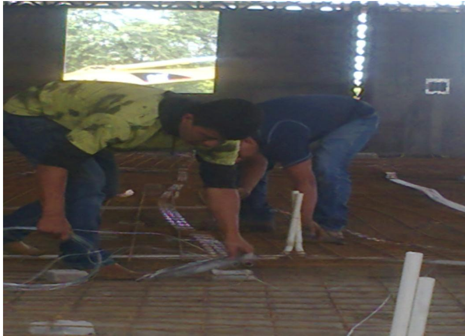
AMARRE DE LAS TUBERÍAS A LA MALLA
