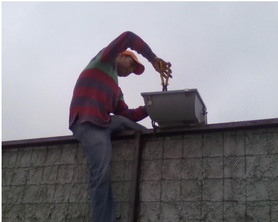
INSTALACIÓN DE LOS REFLECTORES DE 400 W
