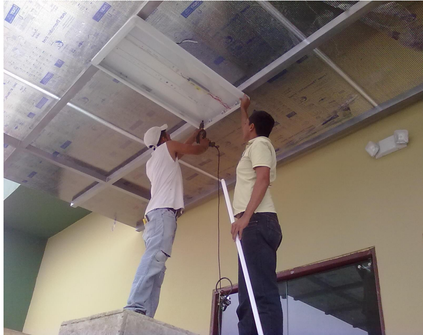
COLOCACIÒN DE LÀMPARAS DE 3 X 32 W
