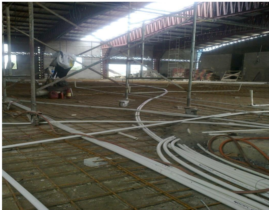
TUBERÍA COLOCADA A LAS CAJAS PRINCIPALES
