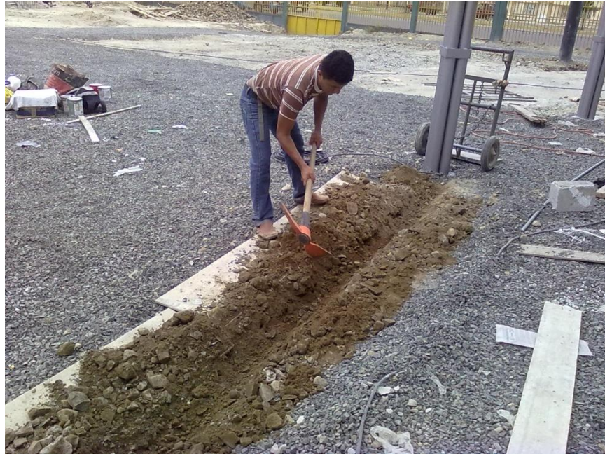
ZANJA PARA LA COLOCACIÓN DE TUBERÍAS PARA LOS REFLECTORES LED DEL MURAL
