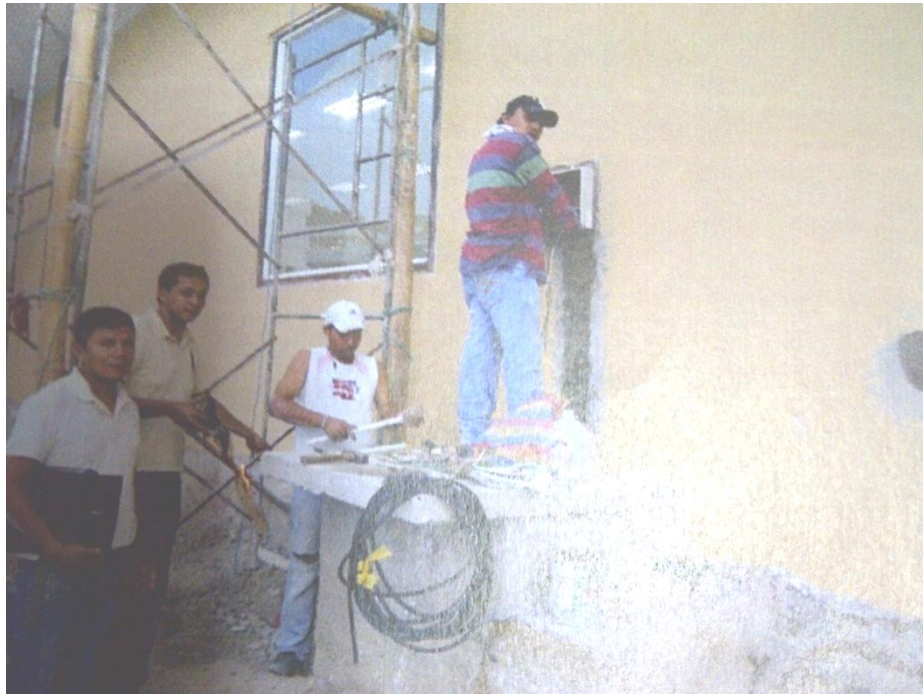
CABLEADO DE LA CAJA DE MANDO
