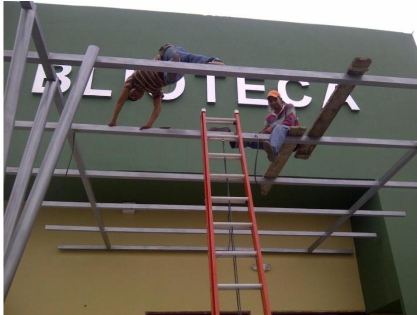
COLOCACIÓN DEL CONDUCTOR PARA LOS REFLECTORES LED DE LETRERO
