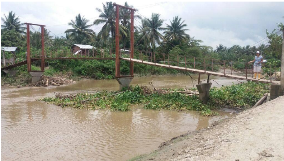
Figura 5. Parte del proceso de la medición del caudal en el sitio Lodana Adentro.
