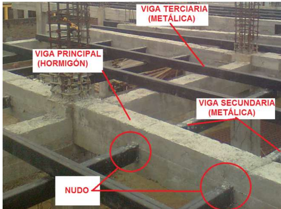
Figura 14 Nudos híbridos (hormigón-acero). (Mieles & Castañeda, 2016)
