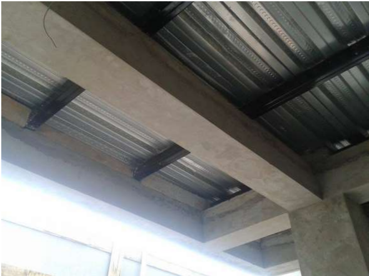
Figura 1 Vigas de acero simplemente apoyadas sobre vigas de hormigón armado.
