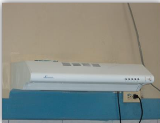
Fotografía 9. Instalación del extractor de olores
