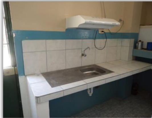
Fotografía 6. Instalación de fregadero con su respectiva grifería.
