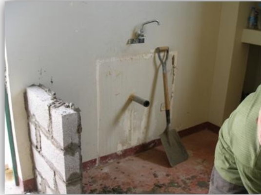
a) Construcción del mesón con fregadero
