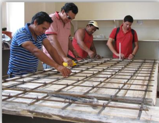
b) Armado del encofrado
