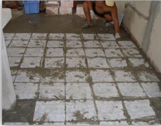
b) Instalación de cerámica
