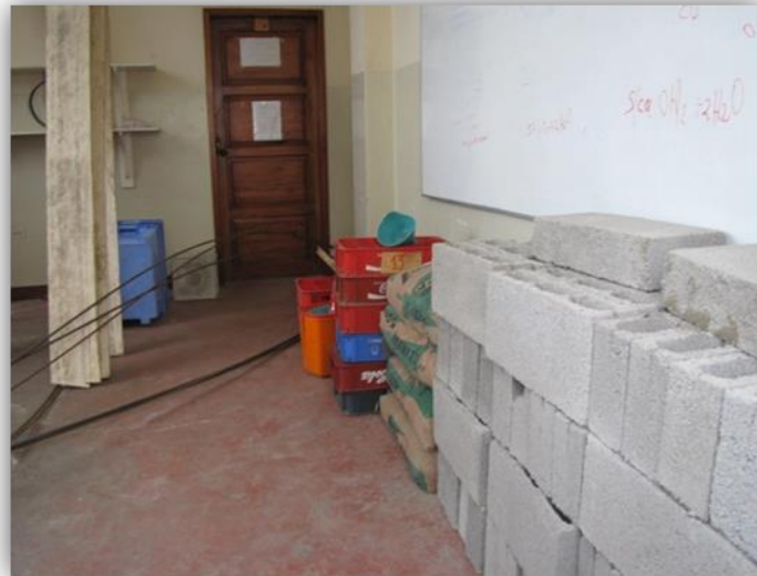
Fotografía 1. Almacenamiento de materiales
