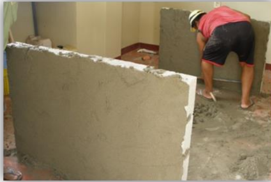
a) Construcción de patas
