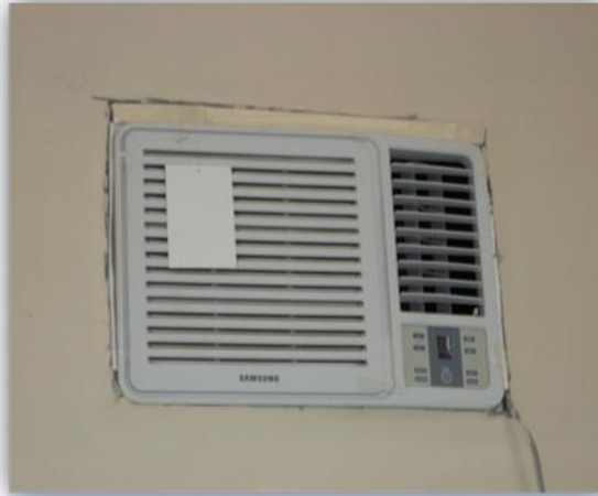
Fotografía 8. Instalación del acondicionador de aire
