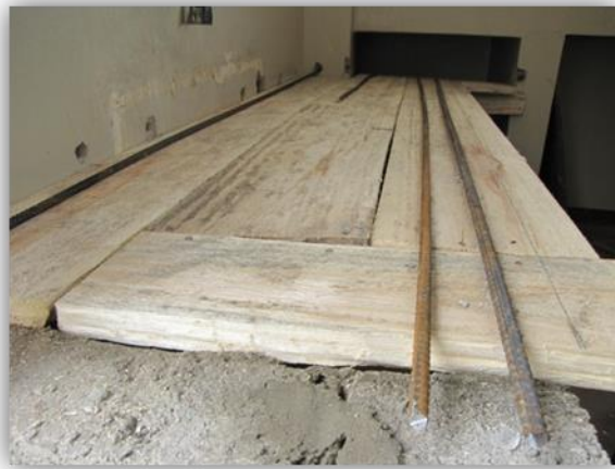
a) Construcción del mesón con fregadero
