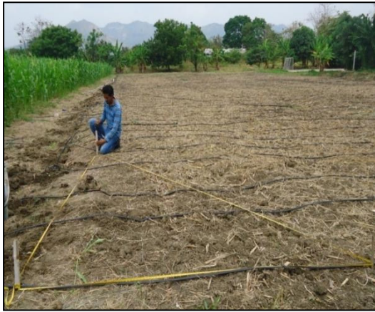
Cuadrado de terreno y alineación de las cintas de riego.
