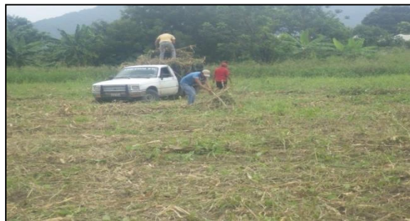
Limpieza del terreno
