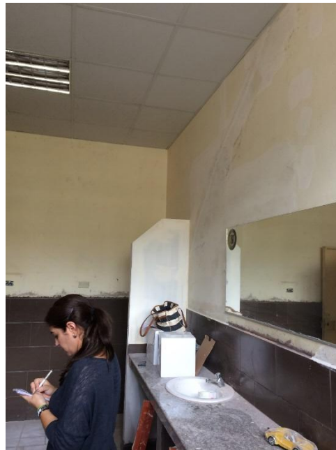
Fotografía N° 24: Lijado de paredes para aplicar el empaste Sika
