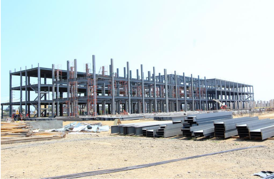
5. Construcción de Hospital de Especialidades Portoviejo, vigas y planchas de acero.
