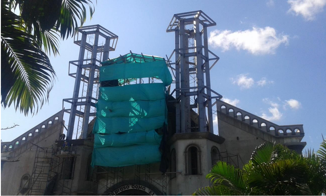
7. Iglesia La Catedral, Portoviejo, reconstrucción de torres con materiales de acero.
