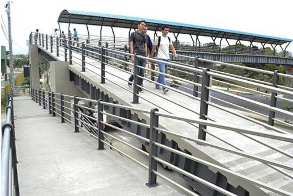
6. Puente peatonal en Portoviejo, estructuras con materiales de acero.
