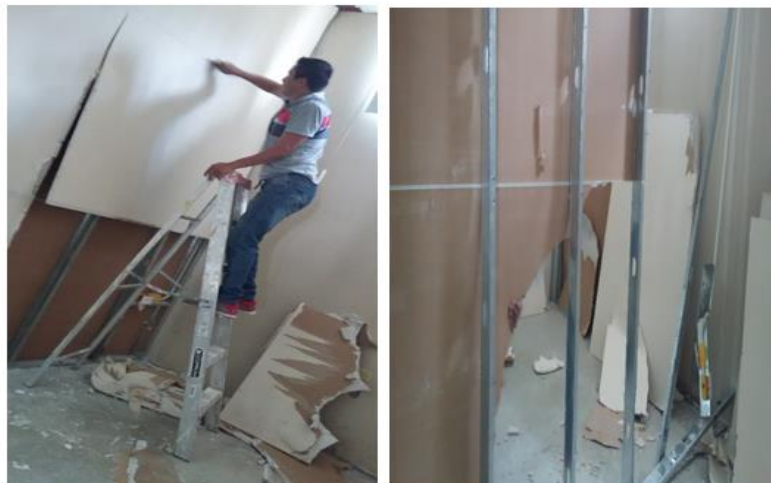
Fuente: Día 1 Extracción de pared de gypsum para ampliar la sala Fecha: 2017-01-17 Elaborado por: El autor
