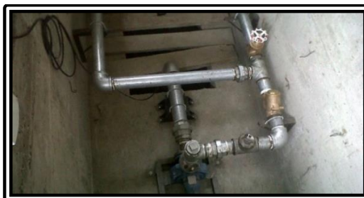
Figura 6. Suministro e instalación de equipo de bombeo, eje horizontal 25 HP
