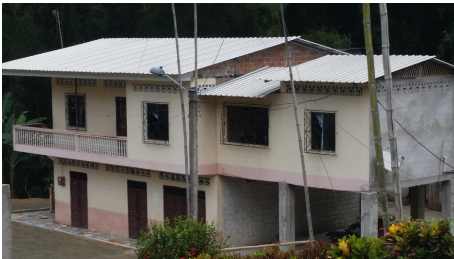
Fig. 9. Vivienda de tres espacios en la parroquia San Plácido
