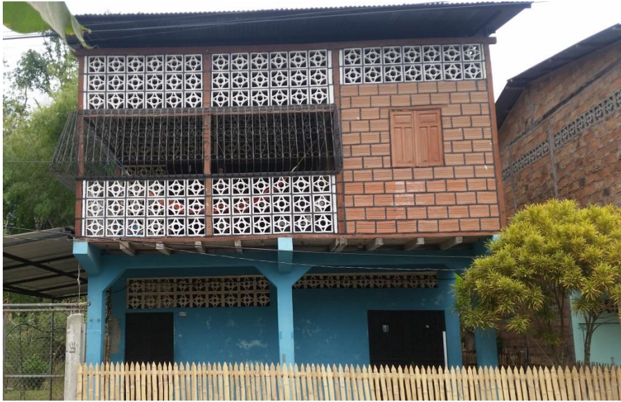
Fig. 10. Vivienda de construcción mixta ubicada en Chirijos
