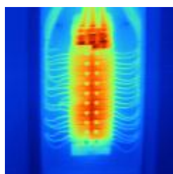
E) Cuadro de interruptores
