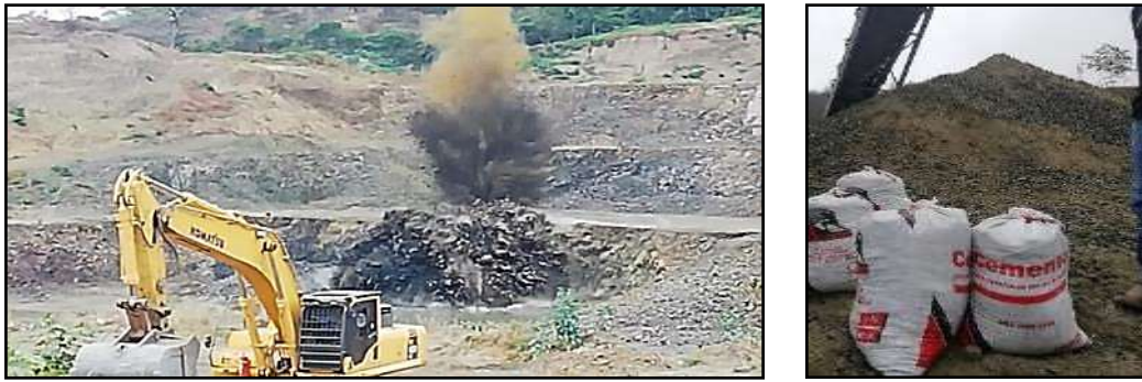
Ilustración 10. Extracción del material granular base y toma de muestra
