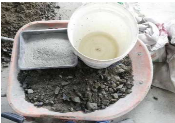
Ilustración 54. Componentes y mezcla de la BAEC.
