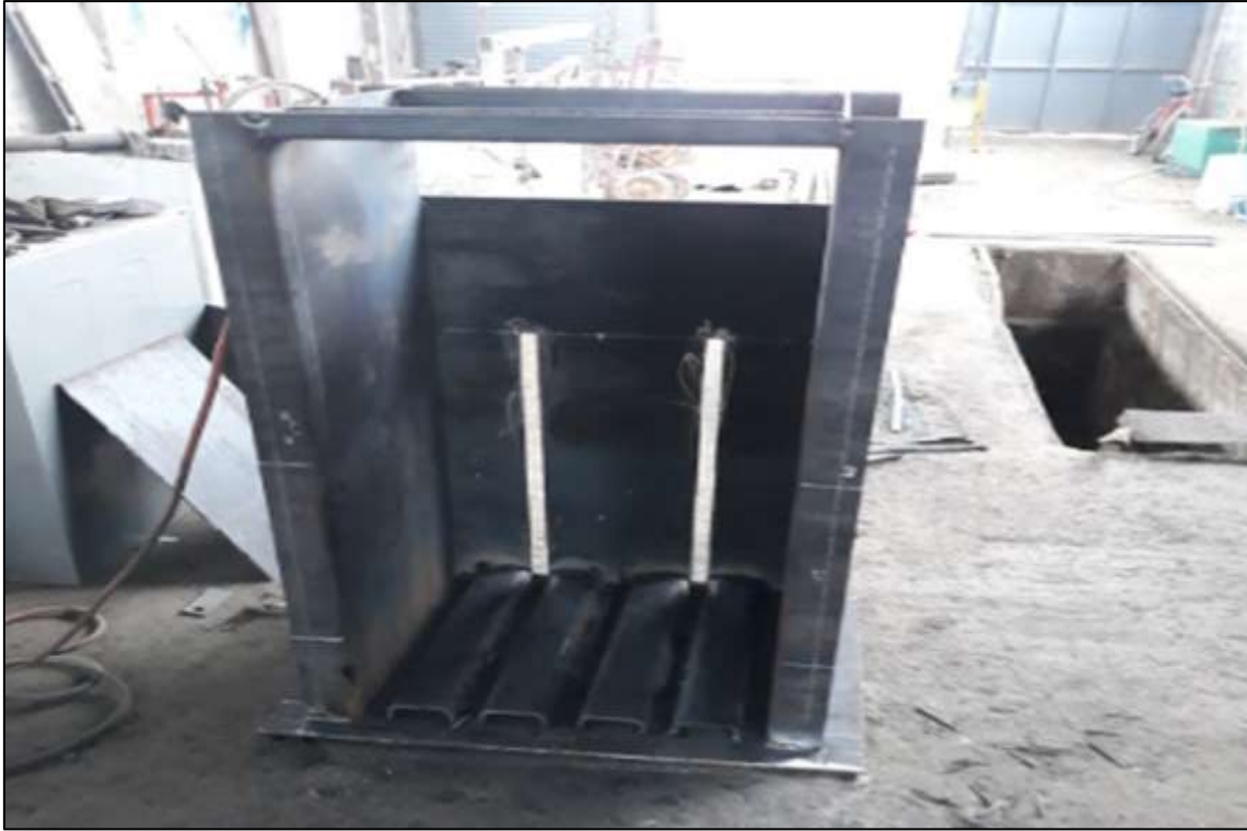
Figura 29. Proceso de unión de las planchas de acero laminado caliente Fuente: Kerly Moreira – Henry Morillo
