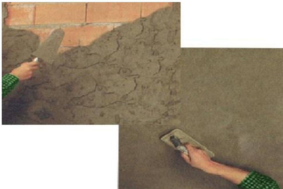
Ilustración 15: Enlucido en capas
