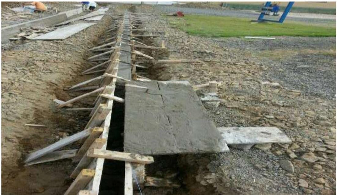
Colocación del hormigón para la construcción de los bordillos de la caminera de la biblioteca central de la Universidad Técnica de Manabí.
