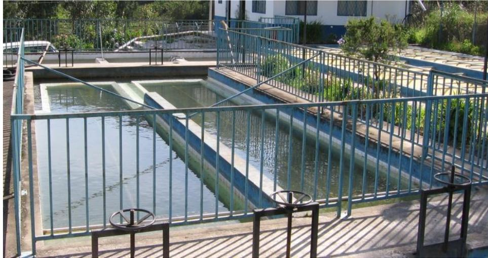
**Fig. 4** Tanque sedimentador
