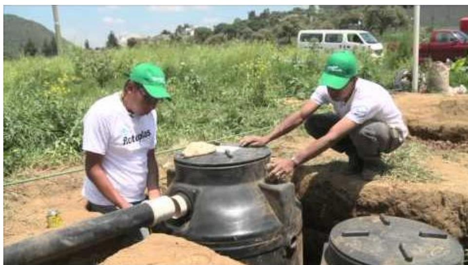
**Fig. 12** Instalación del Biodigestor Autolimpiable
