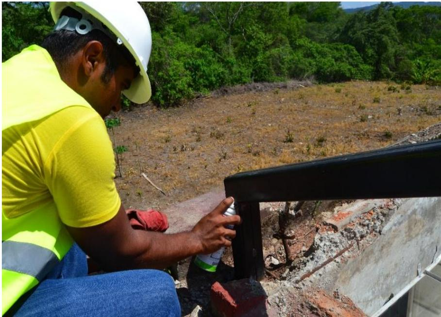
Fig. 2.33 Limpieza del exceso del penetrante
