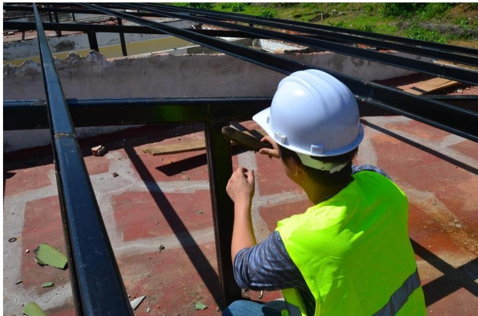
**Fig. 4.8 Limpieza del Cordón de soldadura antes de la inspección visual**
