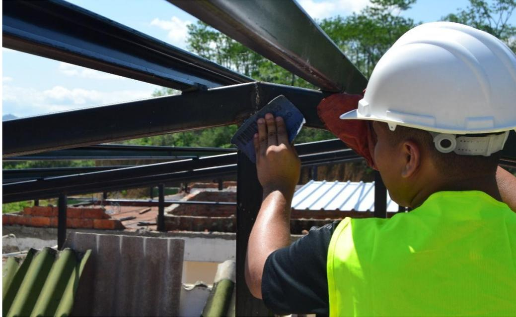
**Fig.4.9 Limpieza del cordón a inspeccionar**
