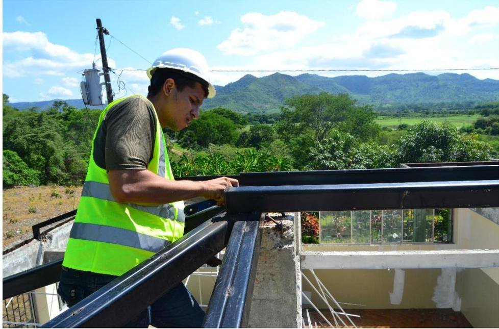
**Fig. 4.7 Limpieza de la escoria previa a la inspección visual**
