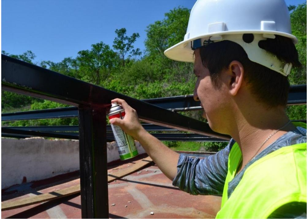
**Fig.4.13 Aplicación de la tinta penetrante**
