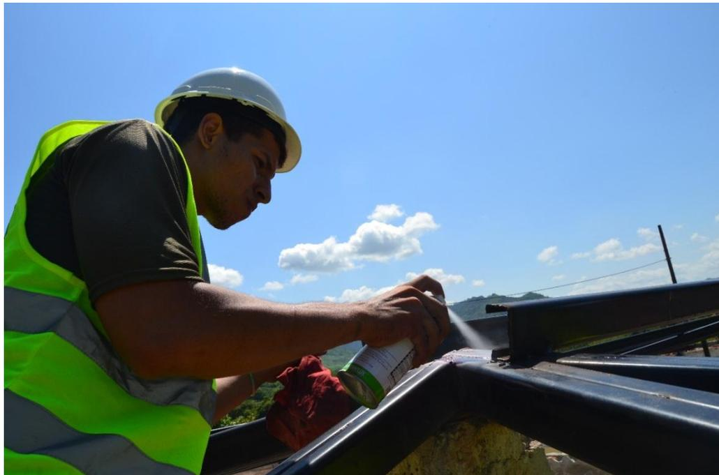
**Fig. 4.10 Aplicación del cleaner para la limpieza**
