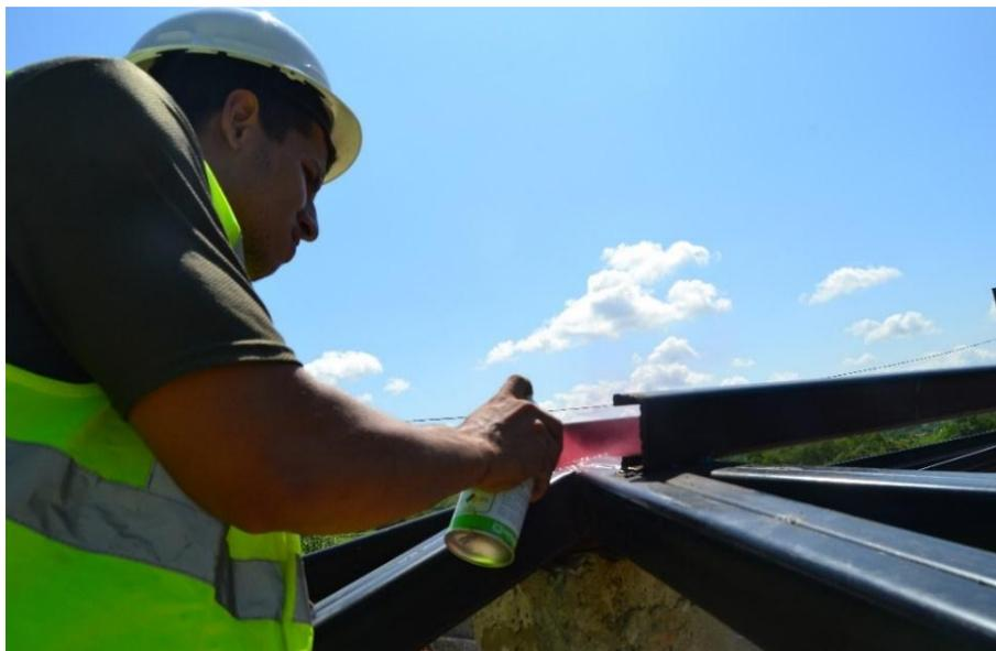
Fig. 2.32 Aplicación del Penetrante
