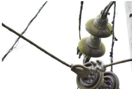
**Figura 5. Aisladores contaminados en redes de 13,8 Kv**
