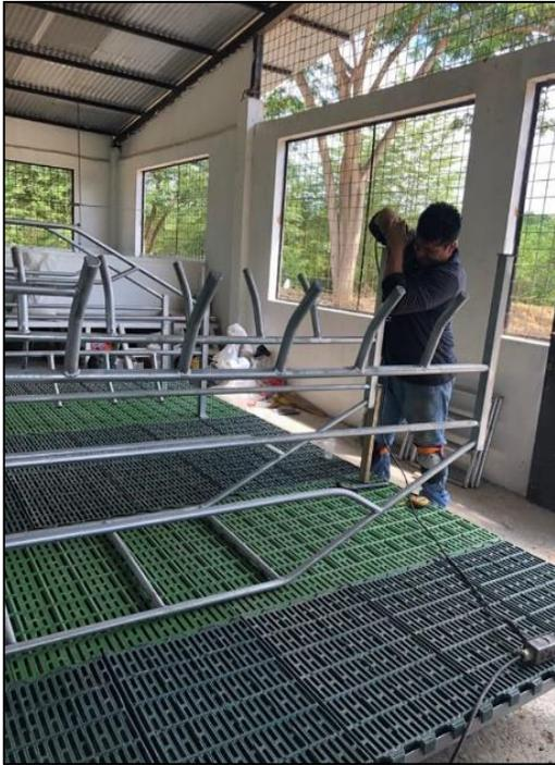
Fig. 13 Fijación de las jaulas de maternidad a la plataforma.
