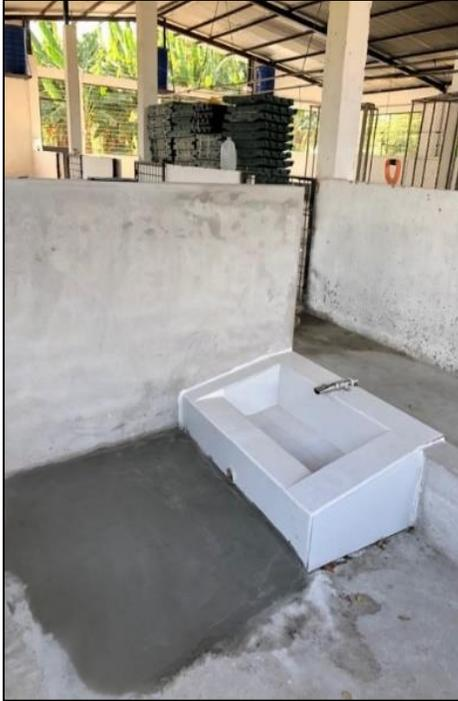
Fig. 5 Rampa de cemento para el bebedero del área de la verraquera.
