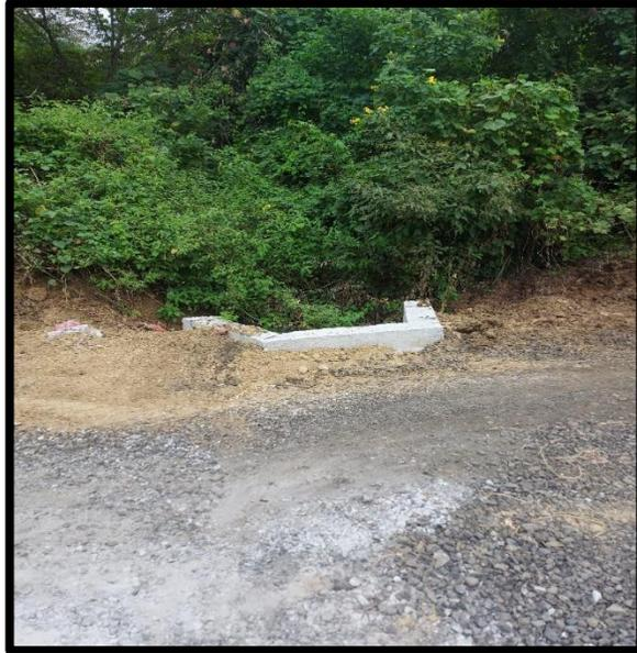
Elaboración de los cabezales del alcantarillado, tanto el cabezal de aguas arriba como de aguas abajo.
