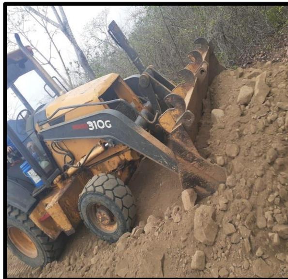
Tendido de la capa sub-base con un espesor de 20cm para posterior hidratación y compactación.
