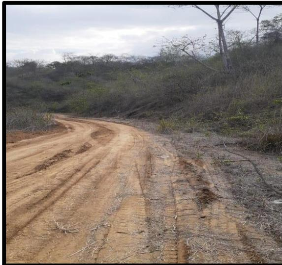
Nivelación de las vías, previo al acarreo del material a usar en la capa sub-base.
