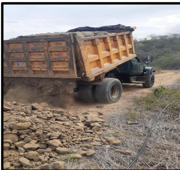
Acarreo del material granular que se usó en el tendido de la capa sub-base.
