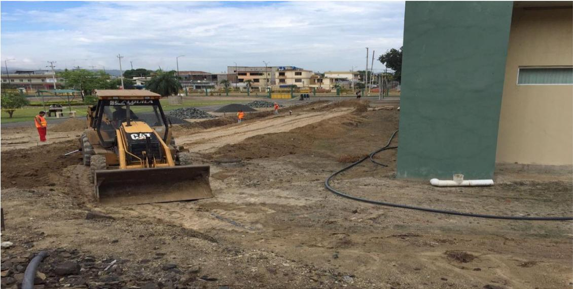
**Foto. 5** Excavación a máquina para cambio de suelo.
