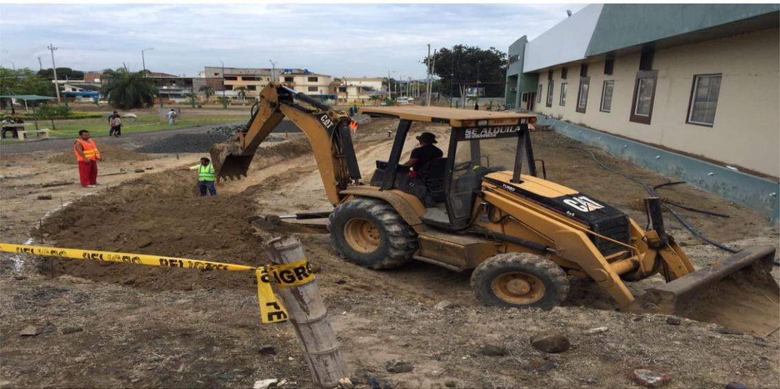
**Foto. 6** Excavación a máquina de zanja para la construcción del espejo de agua.
