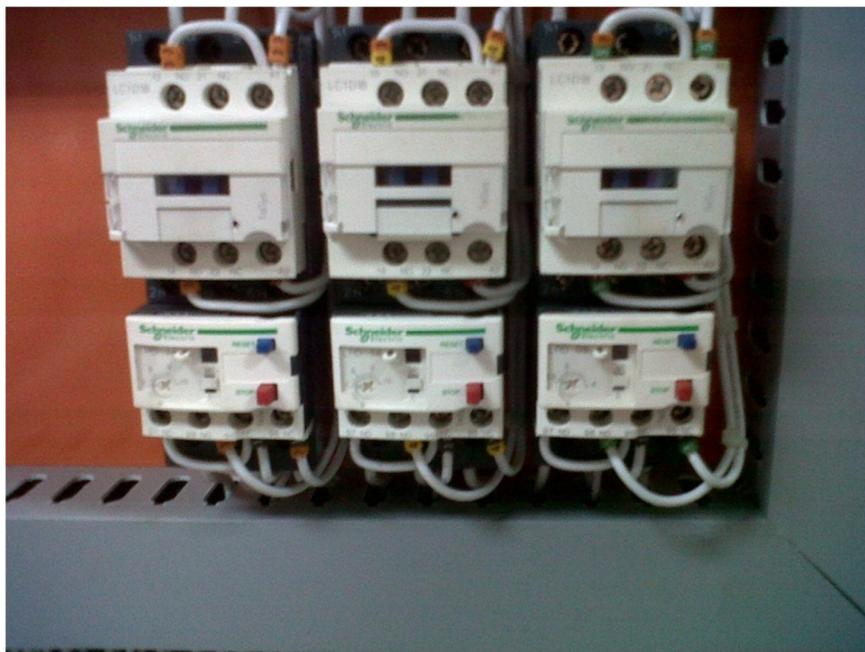
**Fig. 3** Contactores y Relés térmicos
