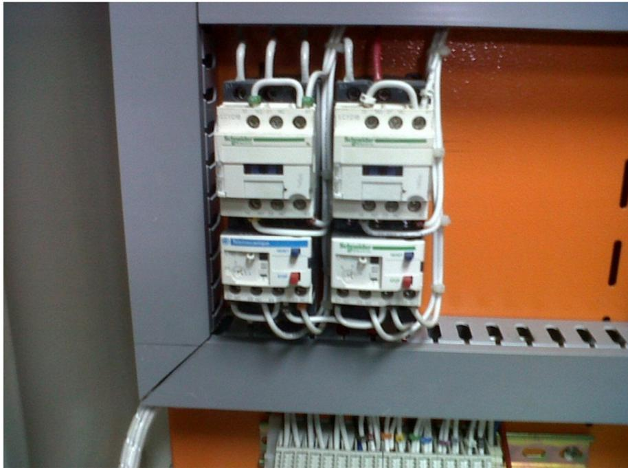
**Fig. 7 Contactores y Relés de caja de control secundaria**
