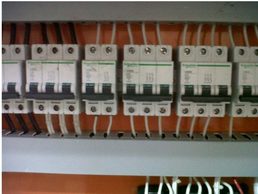
**Fig. 2** Conjunto de breaker de la caja principal
