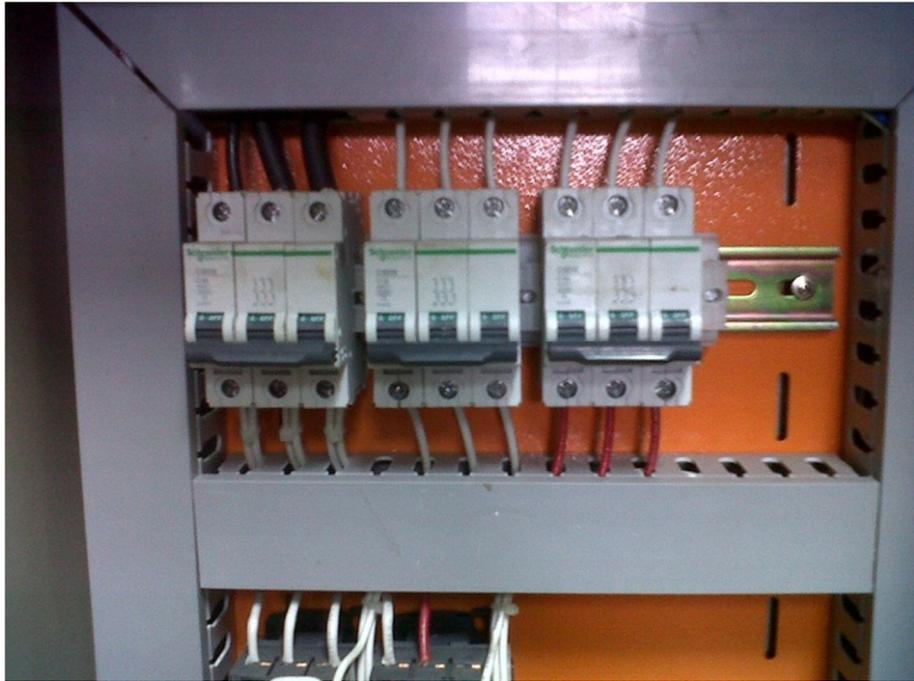
**Fig. 6 Breakers de caja de control secundaria**
