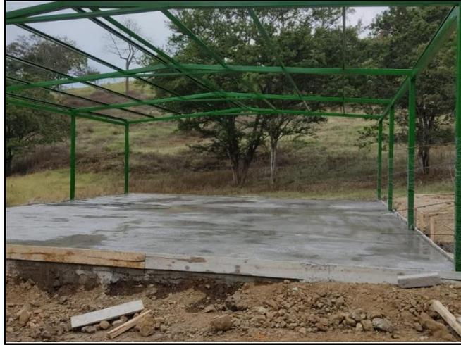
**Anexo No. 7:** Levantamiento y pintado de la estructura metálica
