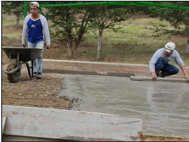
**Anexo No. 5:** Fundida del piso con hormigón simple
