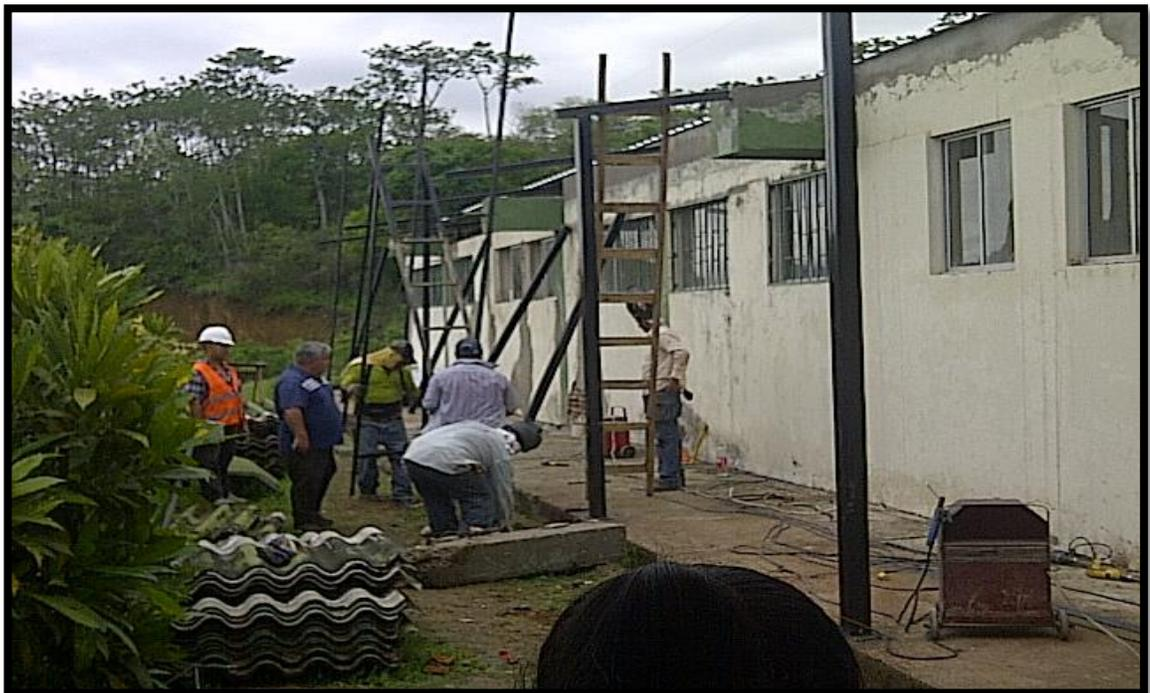
Foto # 32 Colocación de los cajones tipo (O) para el friso
