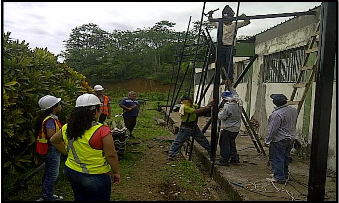
Foto # 33 Trabajo de soldadura de las patas en la parte frontal para el friso.
