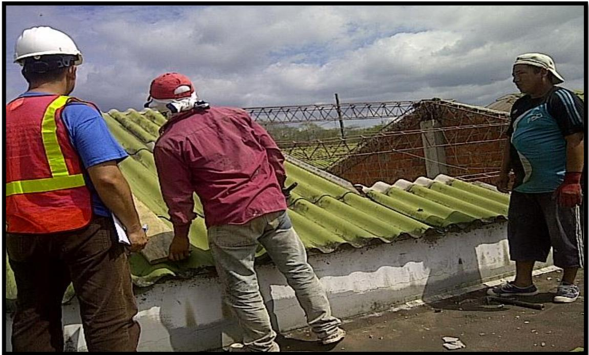
Foto # 8 Desmonte del cubierta (Eternit)
