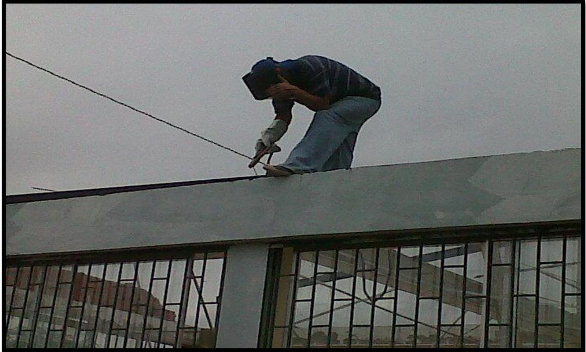
Foto # 23 Soldado de los perfiles tipo cajón sobre la cubierta.
