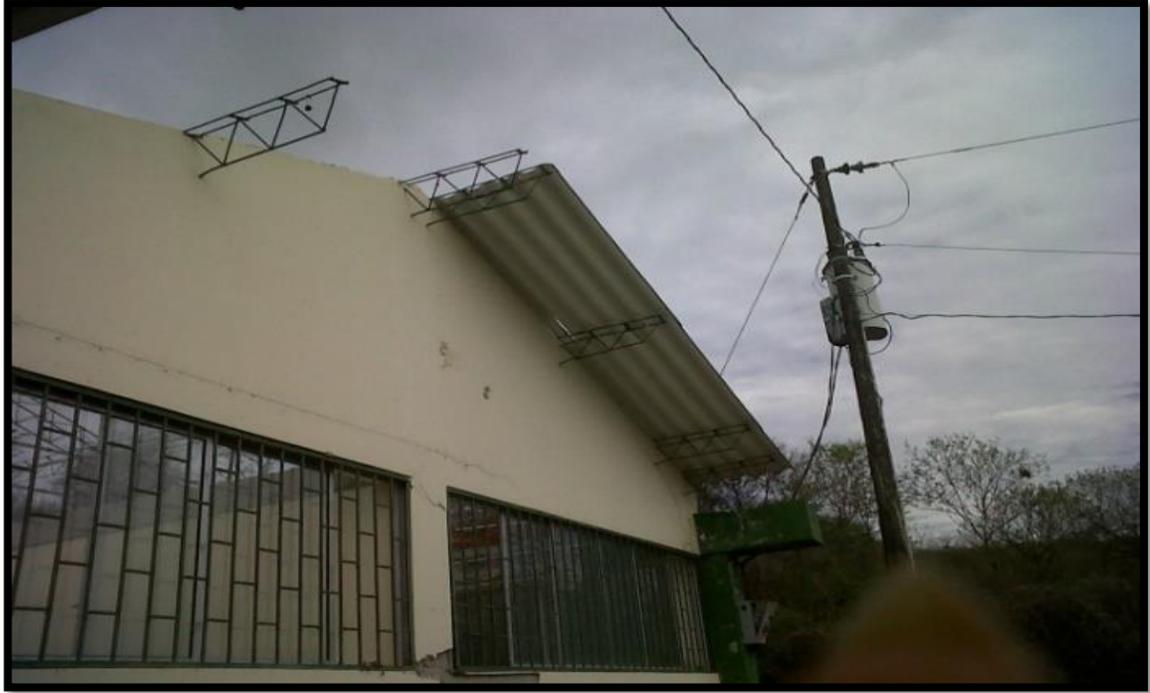
Foto # 7 Desmonte de la cubierta existente.
