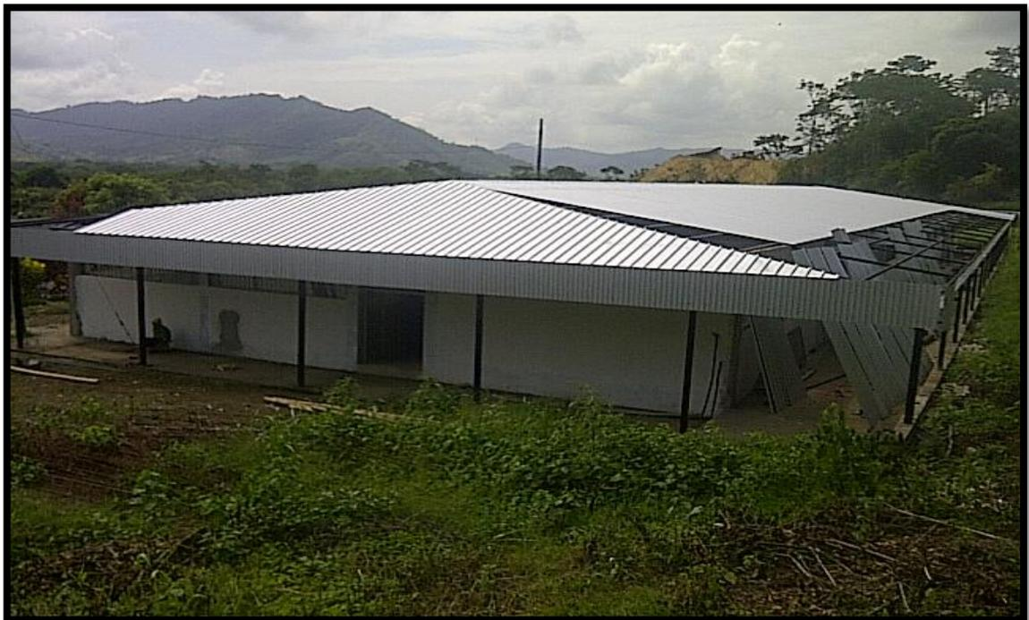
Foto # 30 Avance en un 80% de la colocación de la cubierta (Dipanel)
