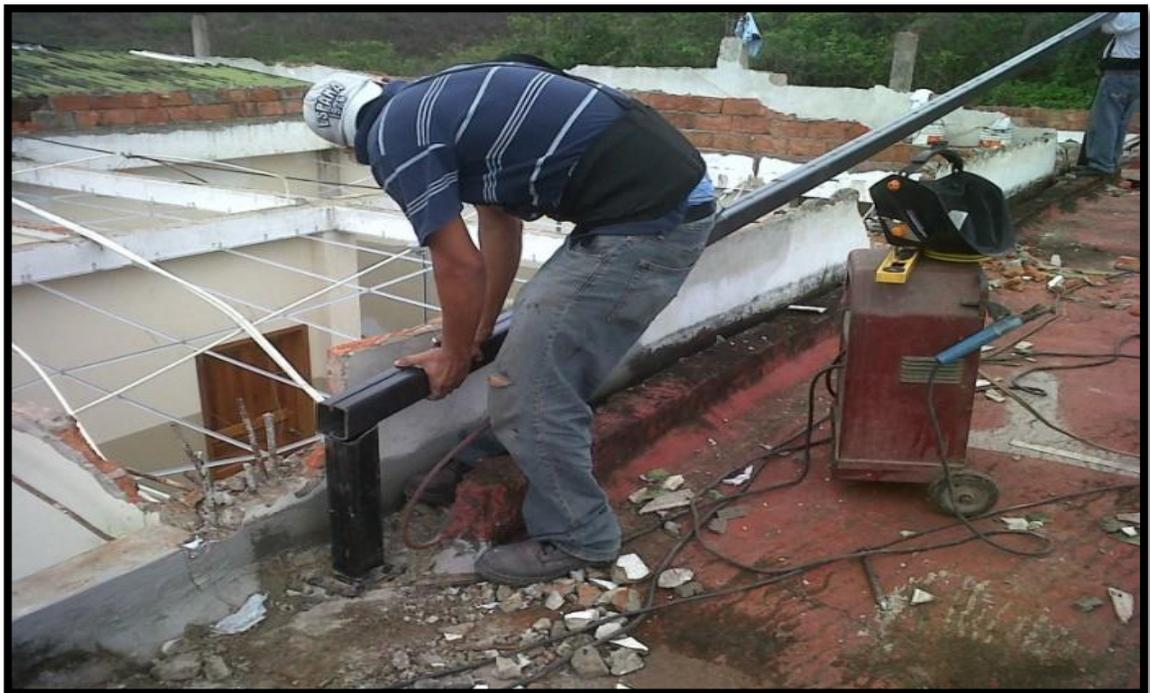
Foto # 24 Ubicación y soldado de los perfiles tipo cajón.
