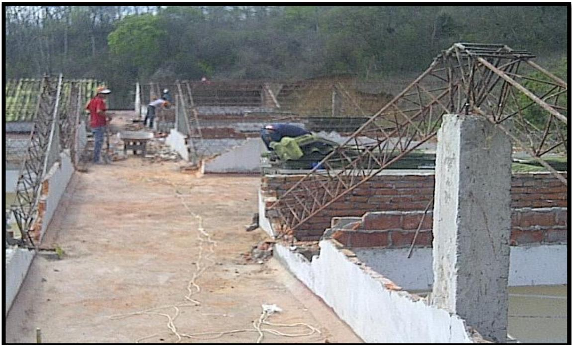
Foto # 12 Desmonte total de la cubierta
