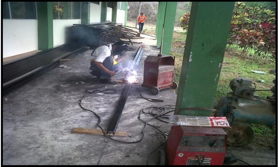
Foto # 15 Trabajo de soldadura de los perfiles.
