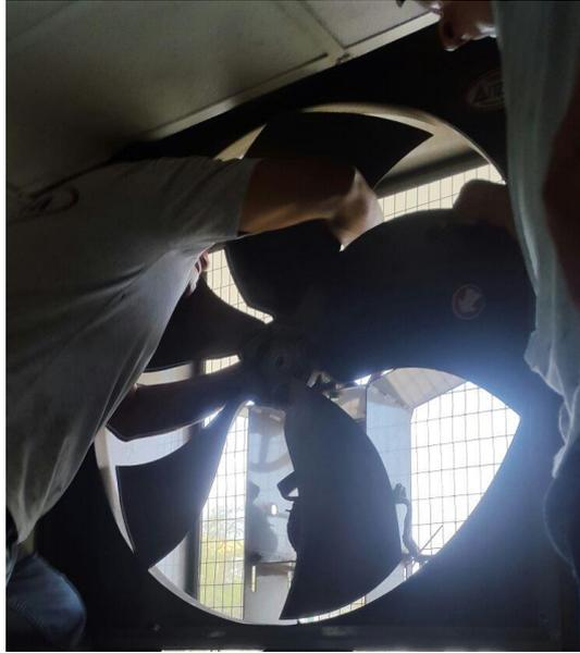
8 Colocación de marco del equipo de ventilación
